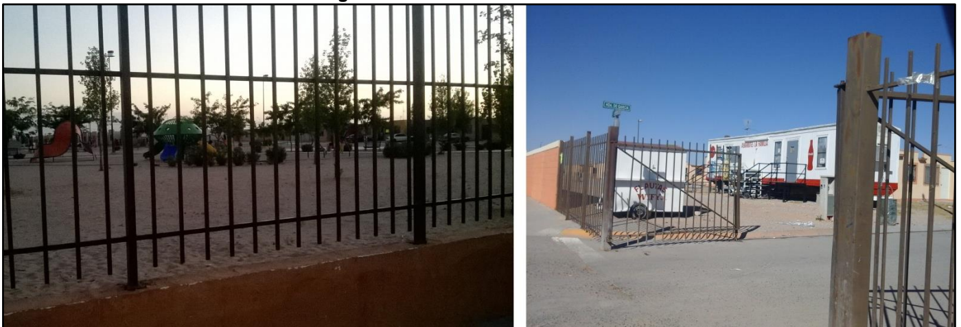
Figura 11. Vista de secciones cerradas
