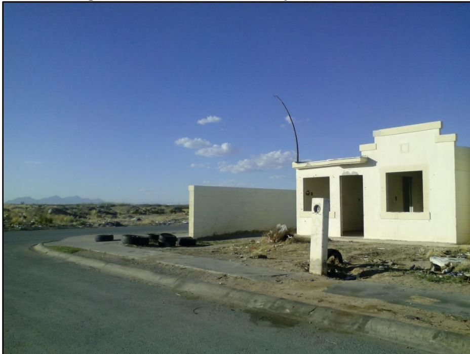
Figura 20. Vivienda deshabitada junto a lote baldío
