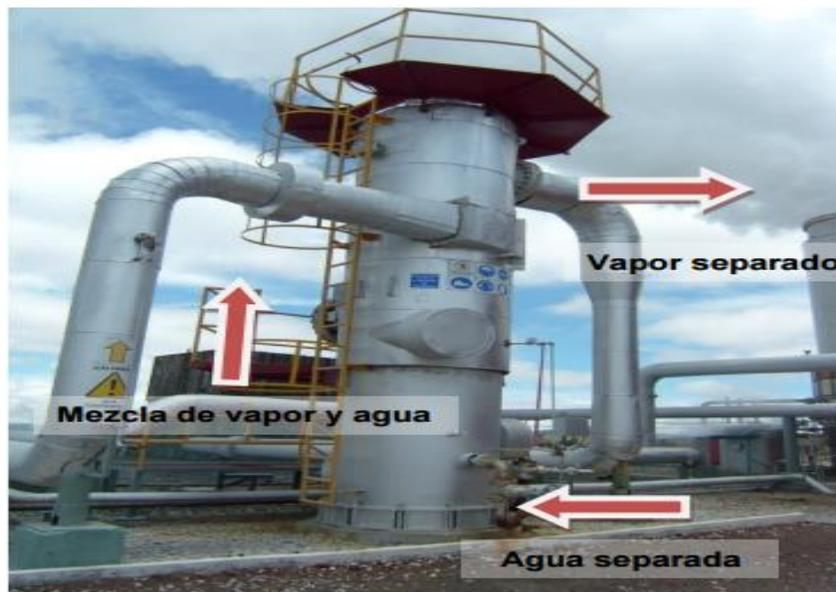
**Figura 70.-** Representación de un separador centrífugo (Equipos de Producción CFE)
