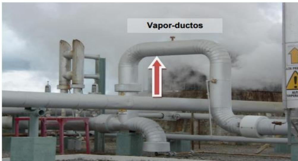
**Figura 71.**-Representación de un vapor ducto (Equipo para la separación de vapor de ductos)
