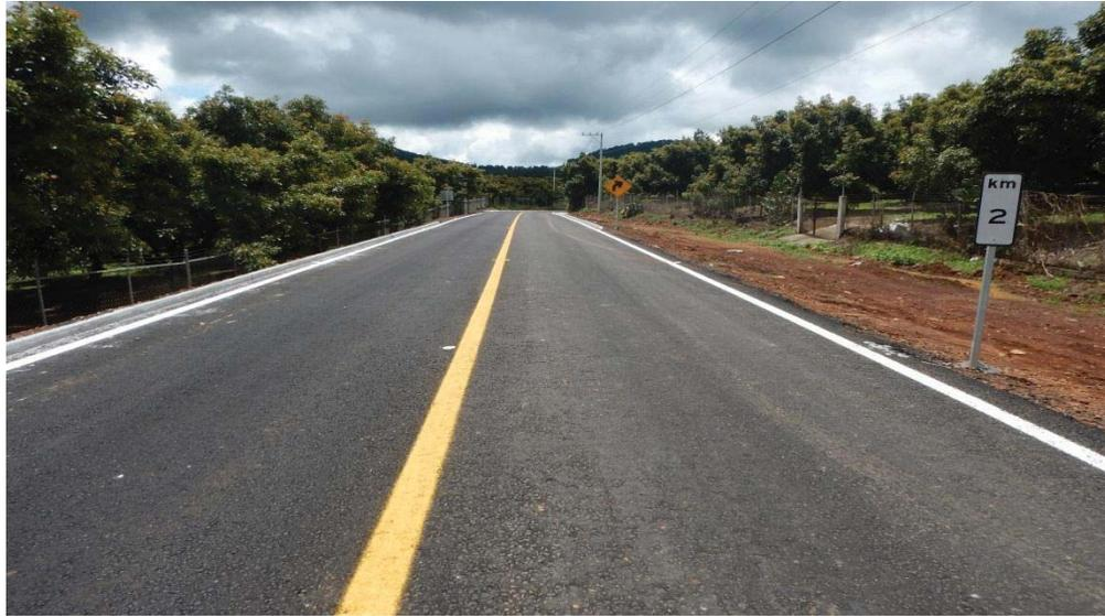
Foto. 5.11 Señalamiento horizontal y vertical
