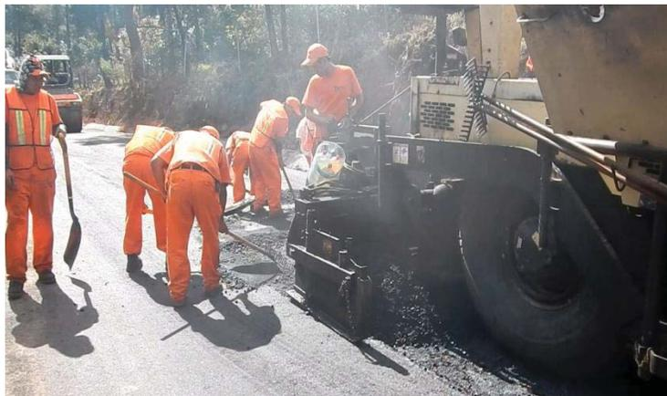
Foto. 5.9 Aplicación de la carpeta asfáltica.
