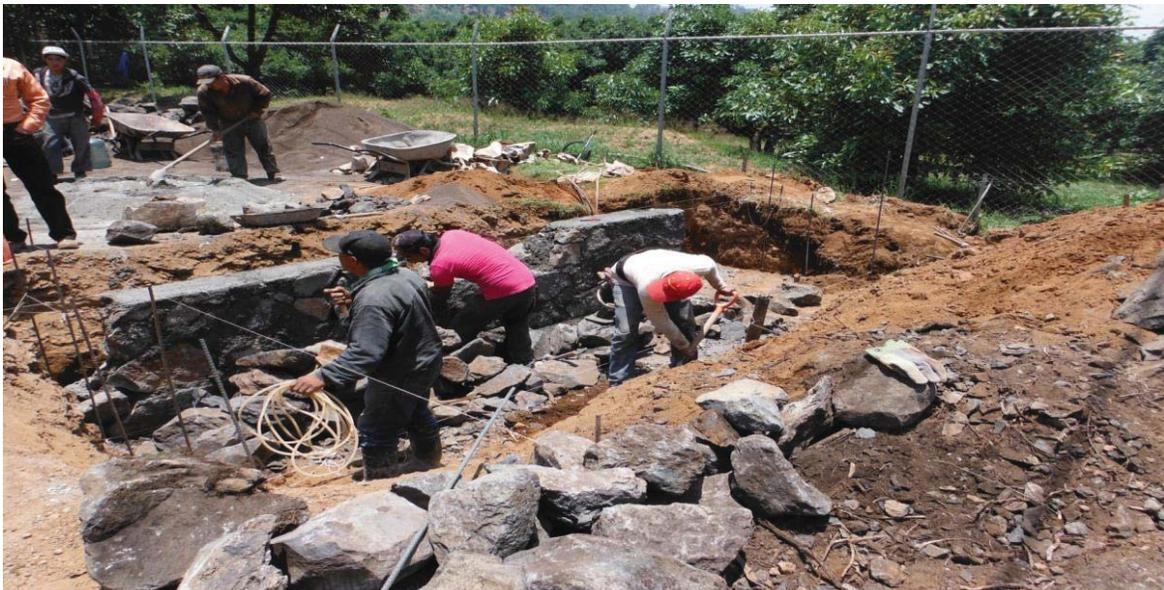
Foto. 5.6 Construcción de alcantarilla de mampostería.
