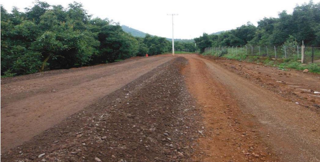
Foto. 5.7 Construcción de la base en el km 2+000.
