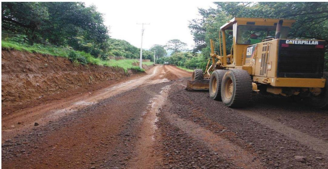
Foto. 5.8 Construcción de la base en el km 2+200.
