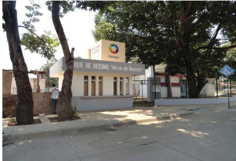
Imagen 3.7. Entrada al campo (previamente rehabilitada)
