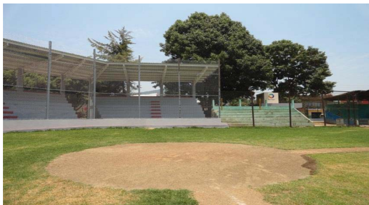
Imagen 3.8. Apreciación de la primera etapa de rehabilitación.
