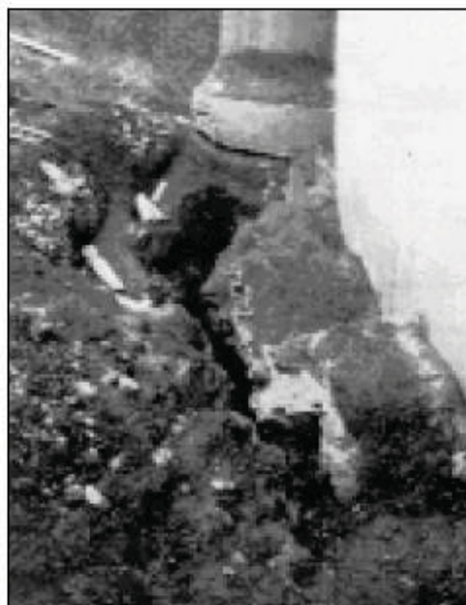
Figura 2. 32 Grieta observada en el arranque de la bóveda, aguas arriba (Londe, 1987)
