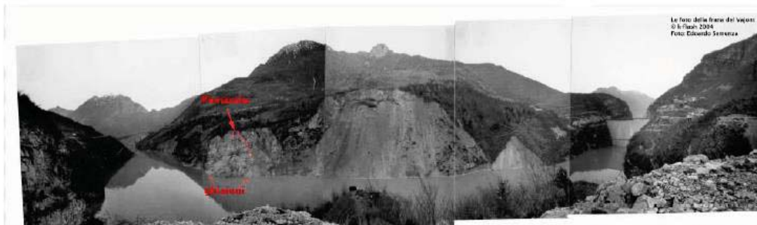
Figura 2. 27 Fotografía tomada por Eduardo Semenza el 4 de noviembre de 1960, se aprecian los deslizamientos del primer llenado y la presa a la derecha.
