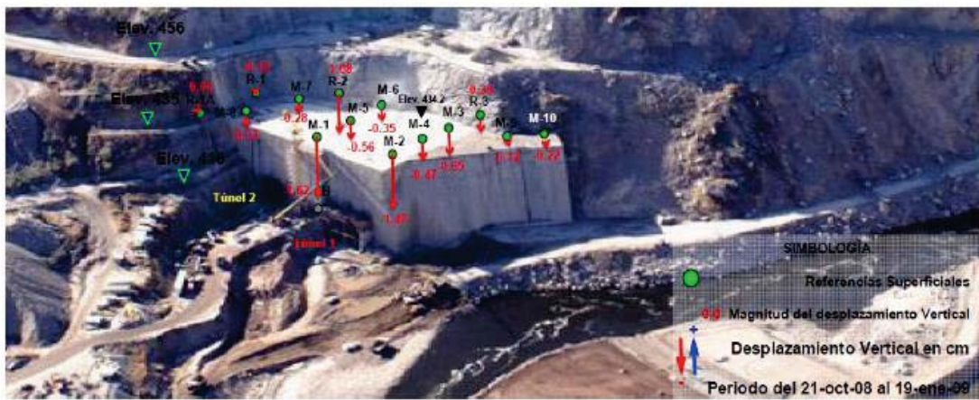
Figura 2. 25 Referencias superficiales instaladas sobre el monolito de atraque, octubre de 2008.
