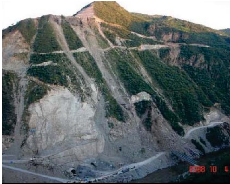
Figura 2. 1 Portal de salida de los túneles de desvió excavados sobre el plano de la falla lavadero, aguas abajo del túnel 2 se observa el bloque deslizado frente al puente Mabey.
