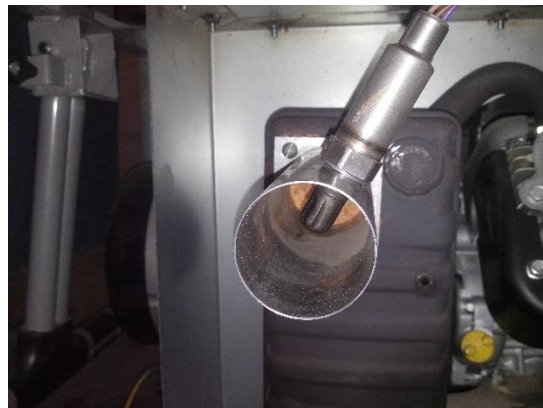
Figura 4.5 Colocación de base, tubo y sensor de oxígeno.
