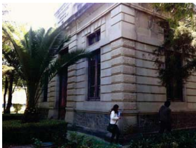
Figura 3.8 Casa de bombas de San Luis Tlaxiataltemalco.
