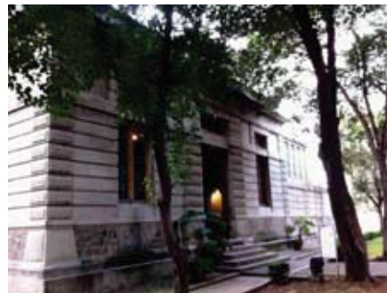
Figura 1.8 Antigua Casa de Bombas.
