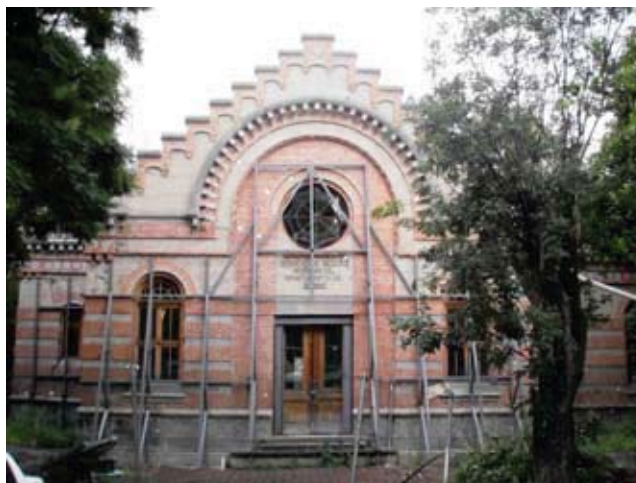
Figura 3.7 Casa de bombas de Santa María Nativitas.
