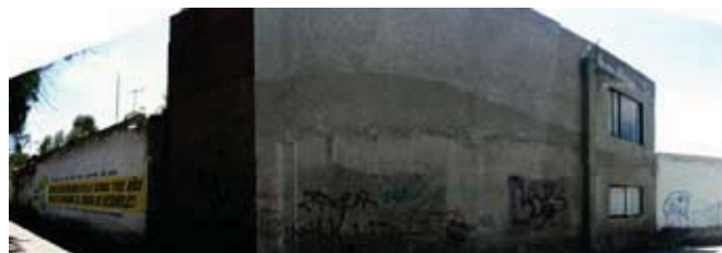
Figura 6.30 Predio en la zona más estrecha del corredor.
