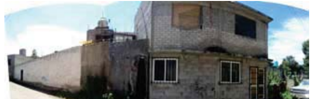
Figura 6.28 Predomina el macizo sobre el vano en lado sur del corredor.
