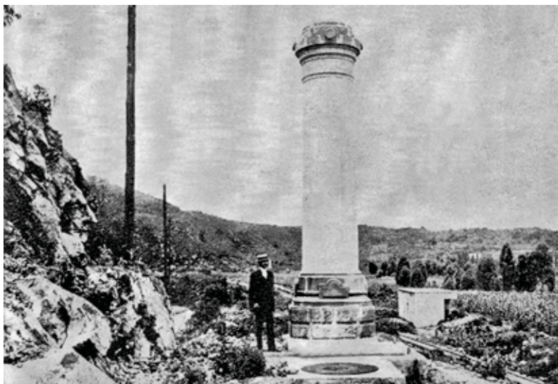
Figura 3.5 Acueducto de Xochimilco.
