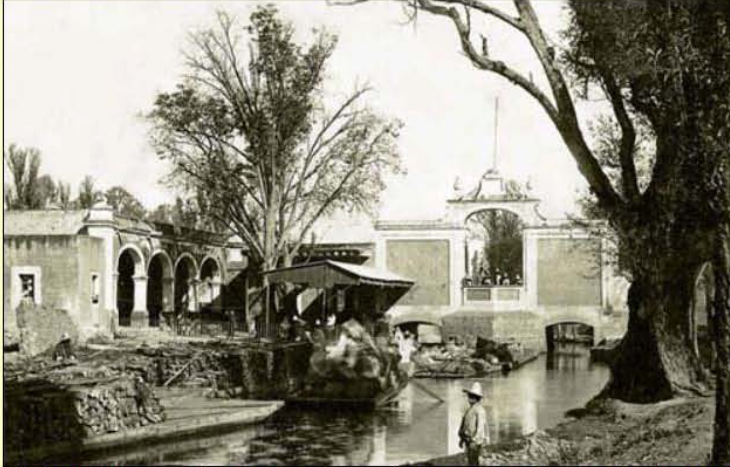
Esta imagen corresponde a un acercamiento de la zona de embarque y los dos pasos inferiores de la Garita de la Viga, aproximadamente en el año de 1900. Se aprecia que la altura máxima de ambos pasos, no pudo haber permitido el cruce de los pequeños vapores. Para 1900, el ciclo de los paseos en barco de vapor se encontraba a punto de terminar, lo que significa que la garita nunca fue modificada.
