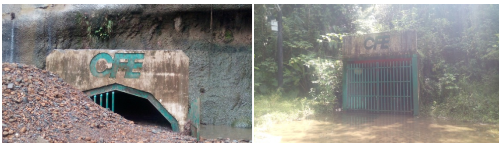
Figura 3.7 Túneles construidos en las tierras de los ejidatarios de Juan del Grijalva.
