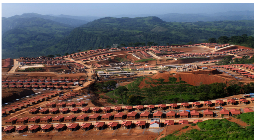
Figura 3.6 Nuevo Juan del Grijalva en construcción.
