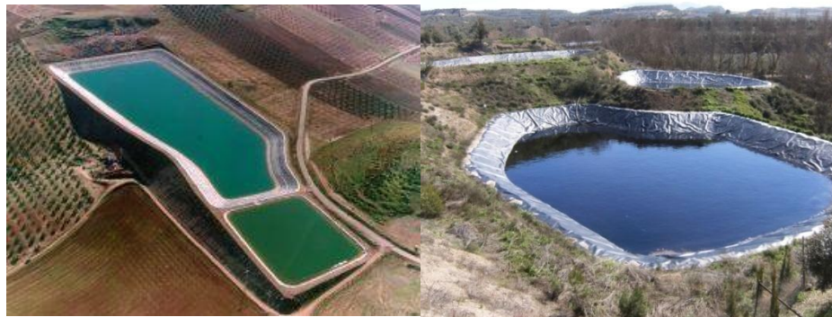
Figura 10. Vista aérea de ejemplos de balsas de estabilización (Hillboe, 2005).
