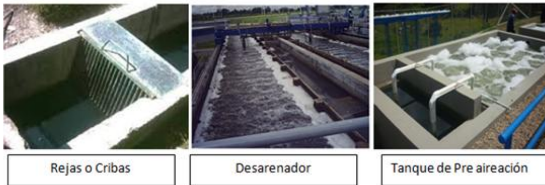
Figura 6. Ejemplos de equipos utilizados en el pre-tratamiento: rejas o cribas, Desarenador, Tanque de Preaireación.
