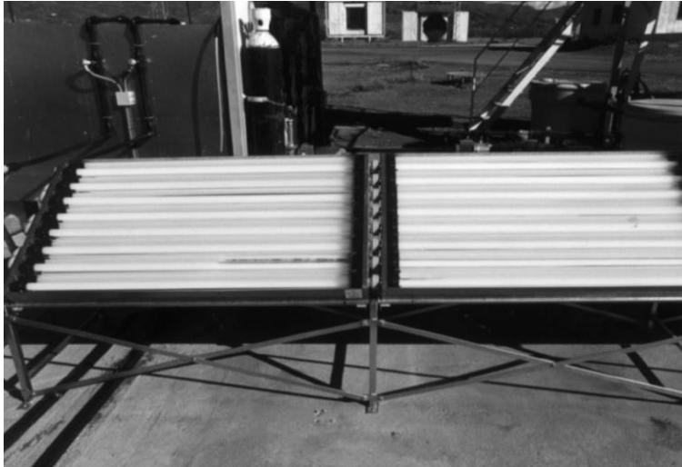
Figura 9. Fotografía de dos concentradores parabólicos compuesto, CPC (Blanco et al. , 2000).
