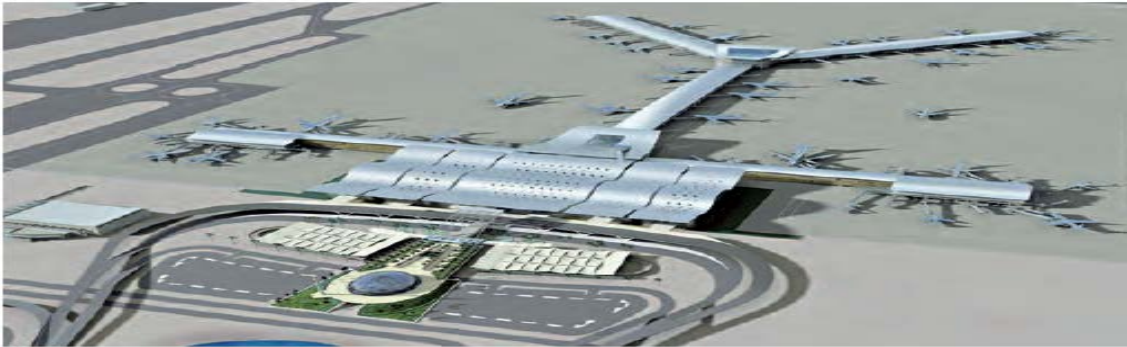
Figura 11: Aeropuerto Internacional de New Doha con tejado de acero inoxidable dúplex.
