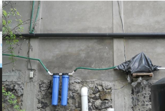
Figura 9. Filtros de papel plisado y carbón activado utilizados en un SCALL instalado por Isla Urbana.
