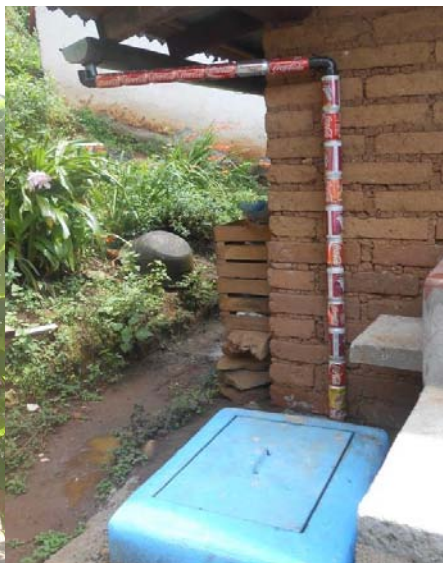
Figura 16. Canaletas y tubos de conducción del techo hacia el filtro de arena de un SCALL de Fondo Pro Cuenca.
