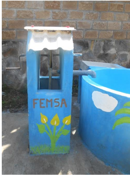
Figura 19. Bomba de mecate para extraer el agua almacenada en la cisterna hacia la pileta en la comunidad de Rincón de Estradas.
