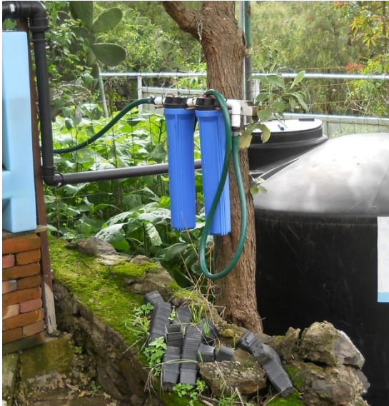
Figura 9. Filtros de papel plisado y carbón activado utilizados en un SCALL instalado por Isla Urbana.
