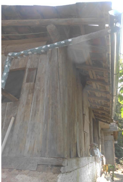
Figura 16. Canaletas y tubos de conducción del techo hacia el filtro de arena de un SCALL de Fondo Pro Cuenca.
