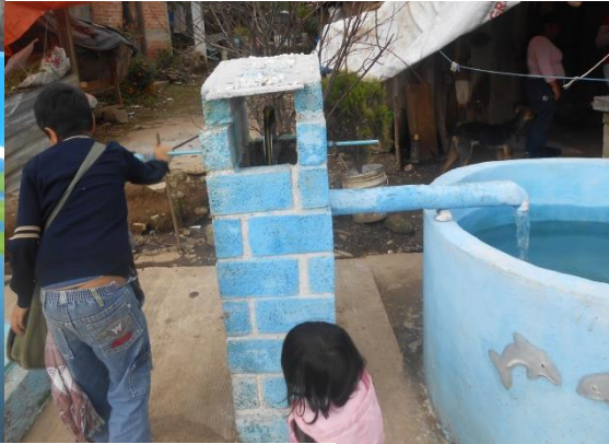
Figura 19. Bomba de mecate para extraer el agua almacenada en la cisterna hacia la pileta en la comunidad de Rincón de Estradas.
