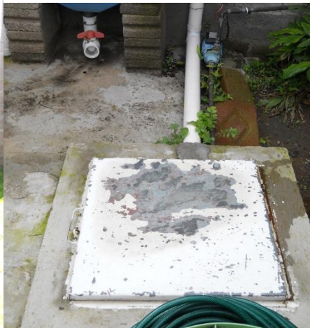
Figura 7. Tinaco implementado por Isla Urbana (izq.) empleado como tanque de almacenamiento. Cisterna enterrada (der.) utilizada para almacenar el agua, en lugar del tinaco.
