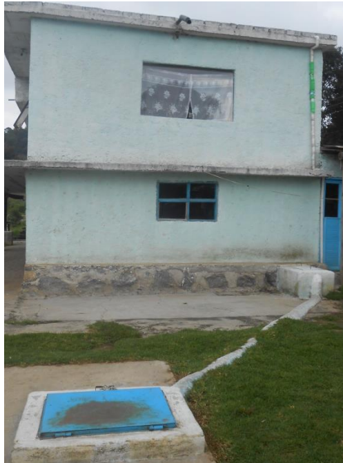
Figura 18. Cisterna enterrada de ferrocemento con tapa de herrería de un SCALL de Fondo Pro Cuenca.
