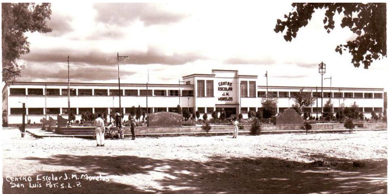
Introducción del funcionalismo a la capital potosina: Vista del Centro Escolar José María Morelos y Pavón, construido sobre lo que había sido el Rastro, al poniente de la Corriente. Fuente: IHSLP
