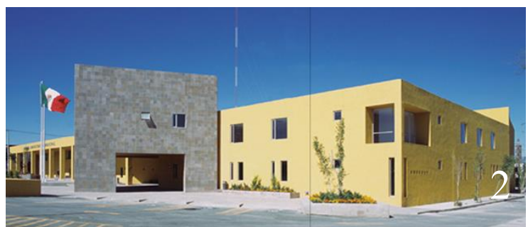
Las primeras generaciones de arquitectos egresados de la UASLP contribuyeron a la búsqueda de una identidad local a la creciente producción de una ciudad en decidida expansión. 1: Ciudad Judicial. 2: Unidad Administrativa Municipal. Fuentes: A. P.
