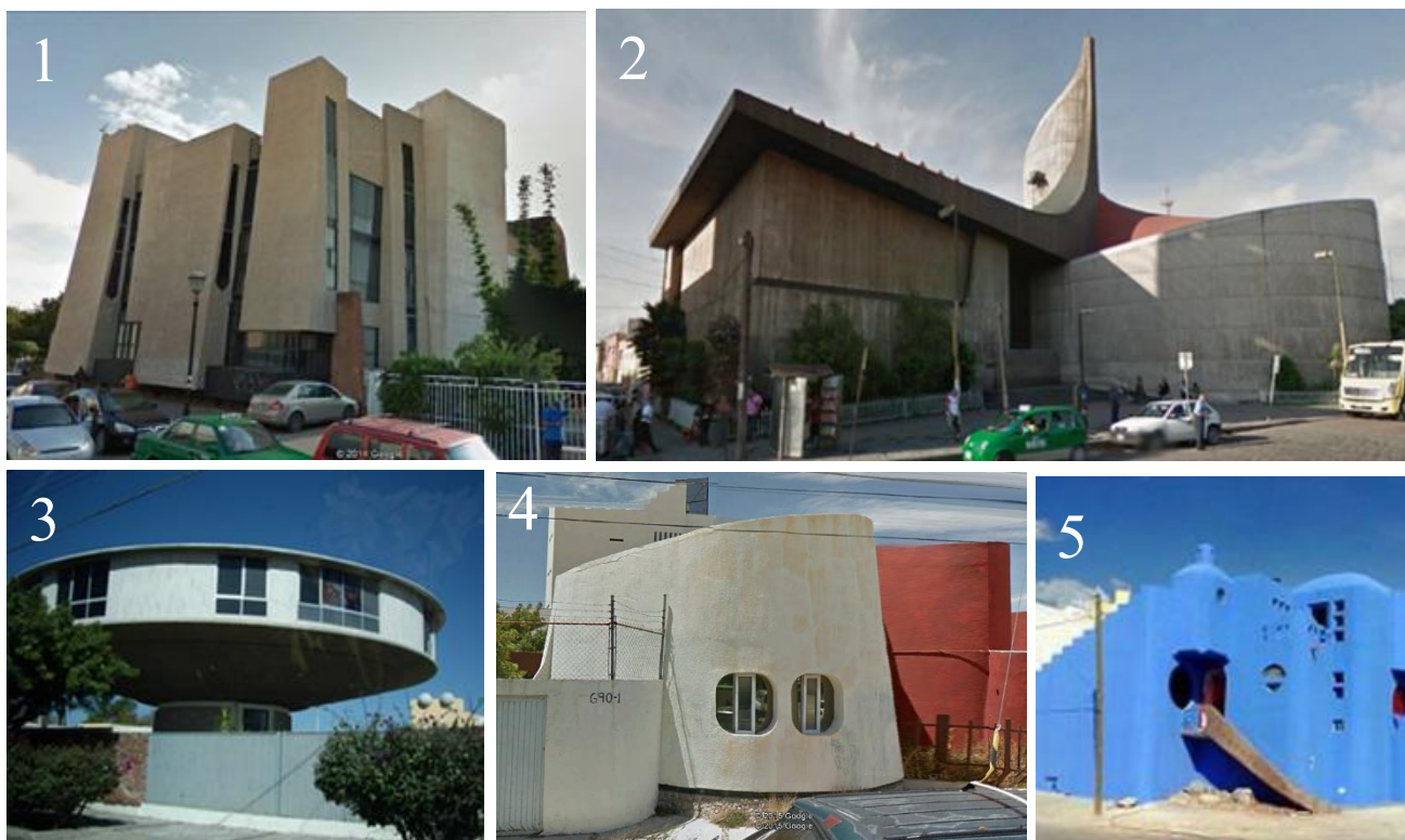
Arquitectura potosina de formas orgánicas, último cuarto del siglo XX. Fuentes: 1, 2, 3, 4: A.P. y 5: Archivo de la arq. Imelda Ortiz.
