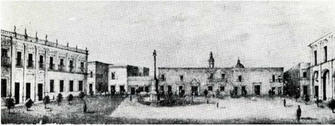
Con la modernidad ilustrada la composición del espacio público adquiere nueva dimensión. Litografía de la Plaza de Armas a mediados del siglo XIX, al fondo la casa de la virreina, izquierda: Palacio de Intendencia, derecha: Ayuntamiento. Fuente: AHESLP.
