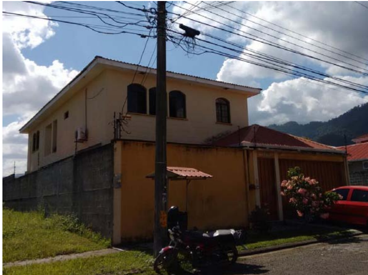
Imagen 33. Fotos de la fachada frontal de la vivienda. Fuente: autoría propia, 2014.
