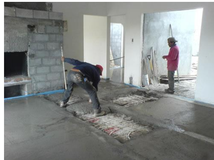
Imagen 21. Colocación del firme final superando 4 cm de la tubería. Fuente: Funcosa, 2014.
