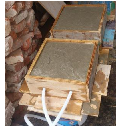
Imagen 45. Mezcla de concreto se vierte en el encofrado. Fuente: Autoría propia, 2014.
