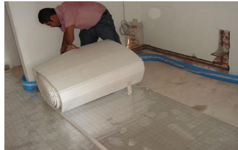
Imagen 17. Colocación del panel aislante en la superficie. Fuente: Funcosa, 2014.
