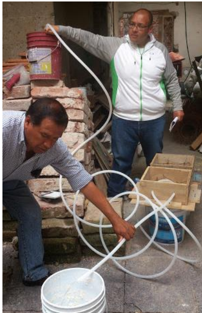
Imagen 44. Prueba para corroborar el flujo del agua en la tubería. Fuente: Autoría propia, 2014.
