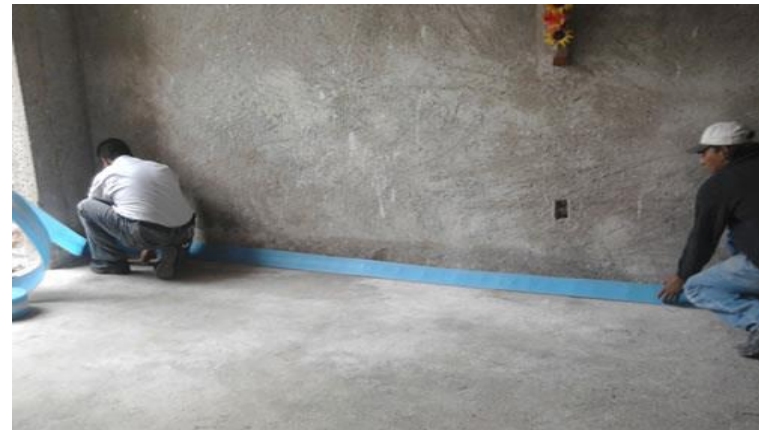
Imagen 16. Colocación de la banda perimetral en el contorno de la superficie. Fuente: Funcosa, 2014.
