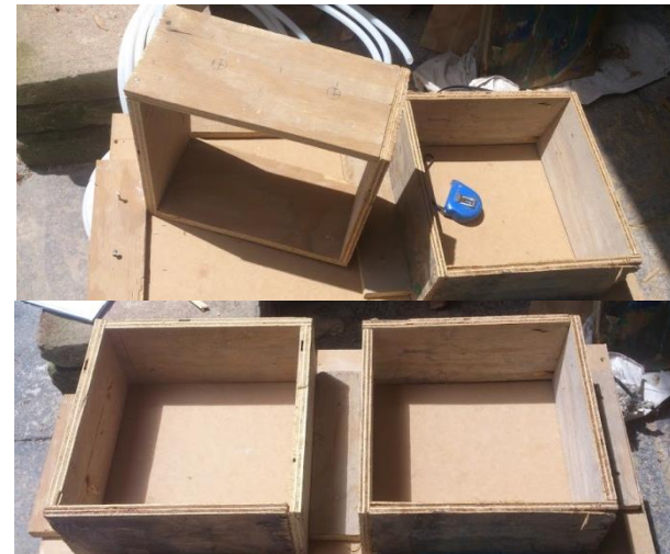
Imagen 42. Realización del encofrado. Fuente: Autoría propia, 2014.
