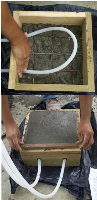
Imagen 47. Colado del bloque de concreto en San Pedro Sula, Honduras. Fuente: Autoría propia, 2014.
