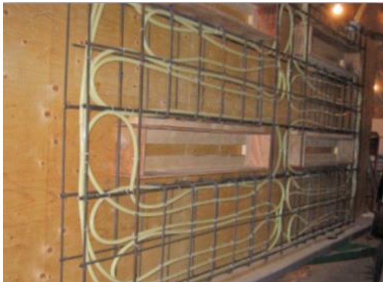
Imagen 5. Panel de pared radiante en forma antes de que se vierta el hormigón. Fuente: (Holmes & MacPherson, 2011)
