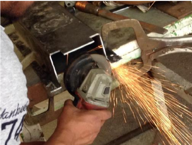
Fotografías 6 Realización del soporte principal de estructura
