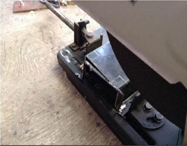
Fotografías 5 Realización del soporte principal de estructura.
