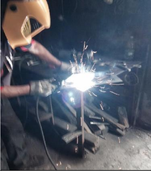
Fotografía8. Unión de piezas estructurales con soldadura.
