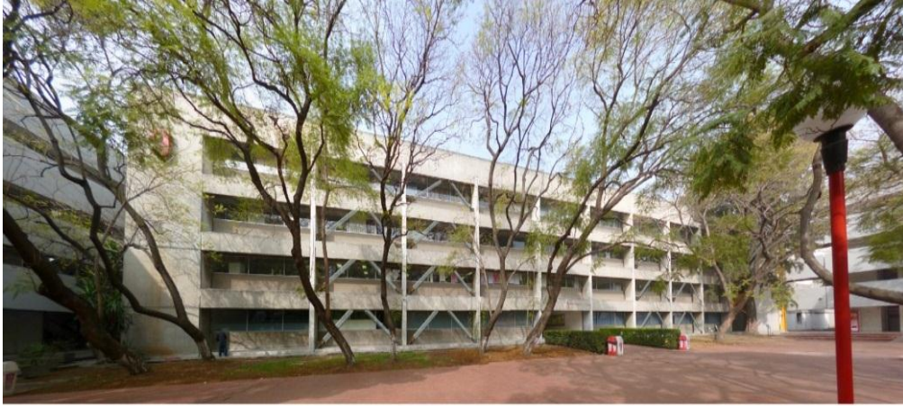
Figura 1.6. Proyecto de refuerzo estructural con contravientos restringidos contra pandeo del edificio G de la Universidad Autónoma Metropolitana Azcapotzalco, montaje fotográfico.
