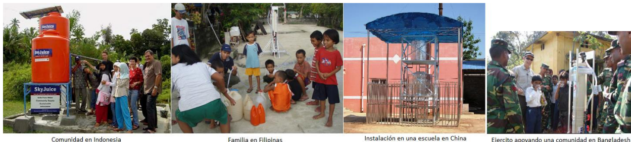
Figura 4.12 Ejemplos de instalaciones de SkyHydrant™/SkyStation™ en Asia.
