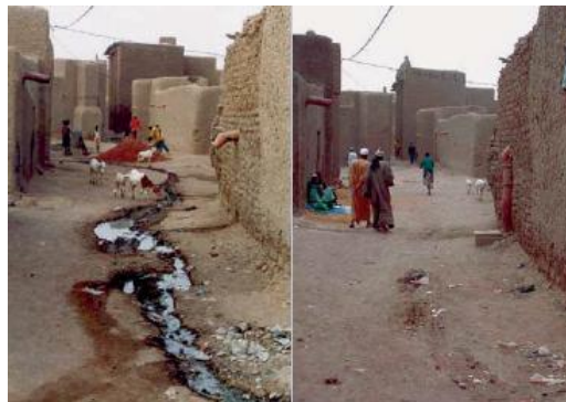
Figura 4.44 Calles de Djenné, Mali antes y después de implementar zanjas de infiltración.
