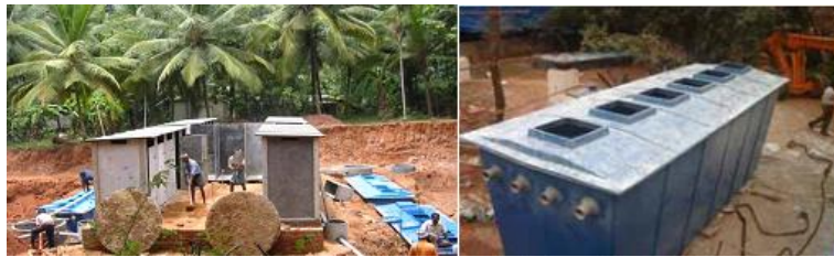
Figura 4.33 Reactores prefabricados instalados en Java, Indonesia.
