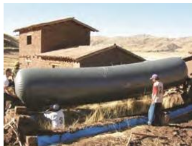
Figura 4.27 Digestor tubular en Cuzco, Perú.
