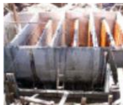
Figura 4.31 Construcción del reactor anaerobio con deflectores en un mercado público en Negros Oriental, Filipinas.
