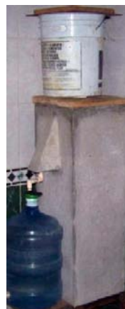
Figura 4.7 Filtro lento de arena en el municipio Atzalan, Estado de Veracruz.
