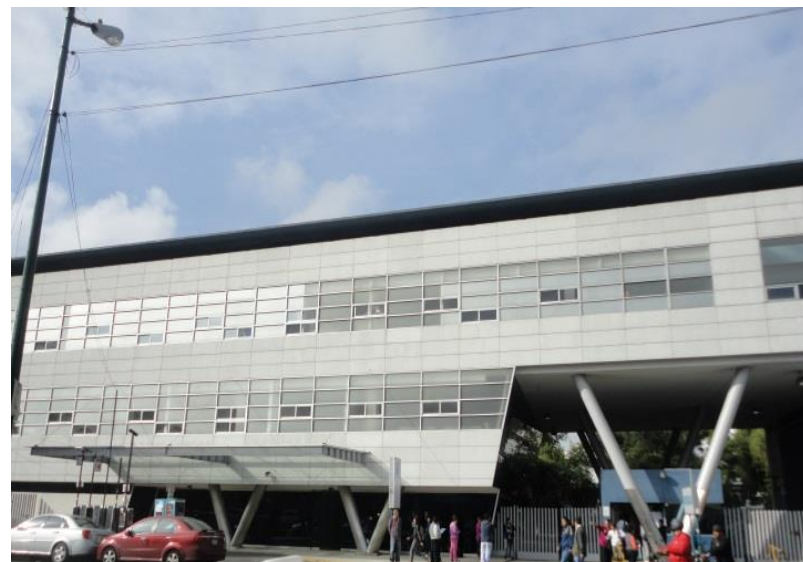
Ampliación de consultorios Hospital 1° de Octubre (en obra)
