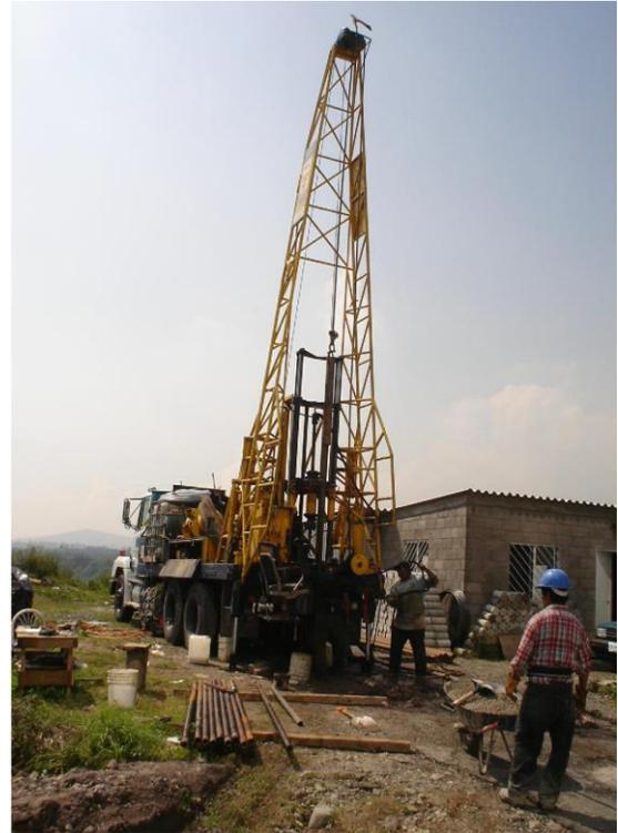
Figura 9.- Sondeo de Penetración Estándar SPT-1.
