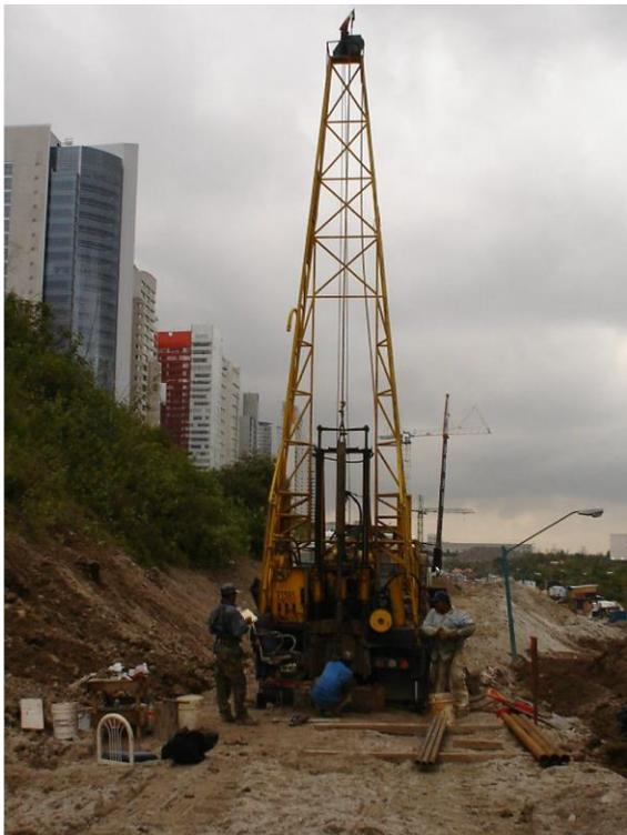
Figura 11.-Sondeo de Penetración Estándar SPT – 4.
