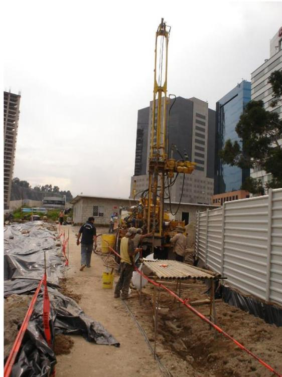
Figura 12.-Sondeo de Penetración Estándar SPT-5.
