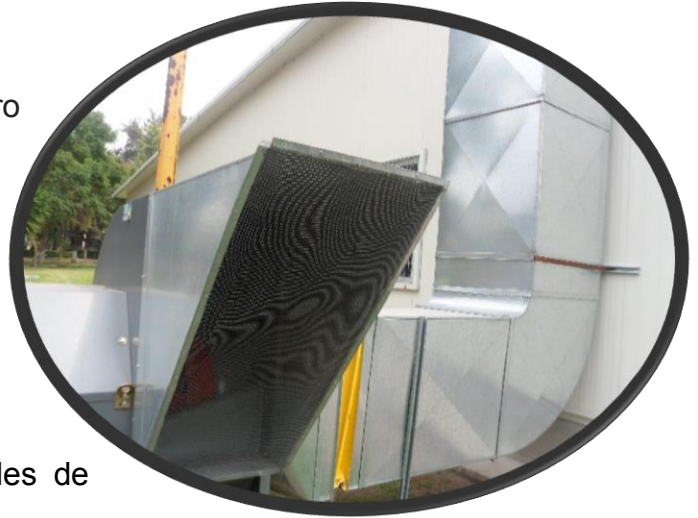
Imagen 7. Sistema de aire externo
