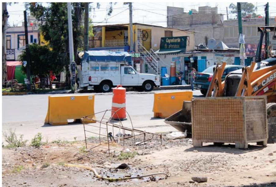
Fig 5.33 Obras de pavimentación en el sitio entre febrero y marzo de 2015
