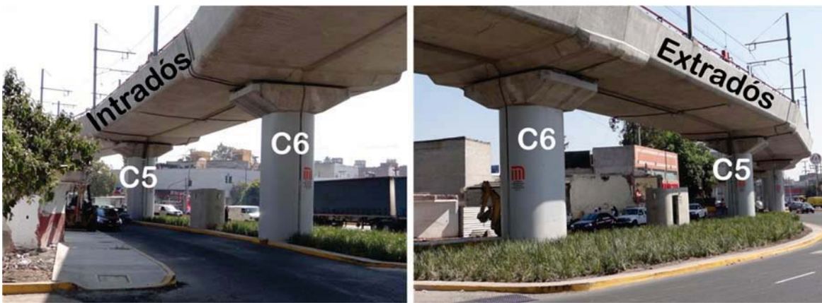
Fig 2.7 Vista del tramo instrumentado y estación central de registro
