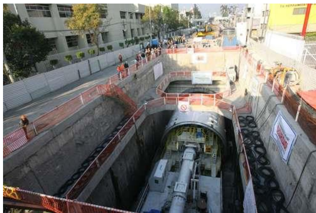
Figura 11. Construcción de “Línea 12” del metro en el Distrito Federal
