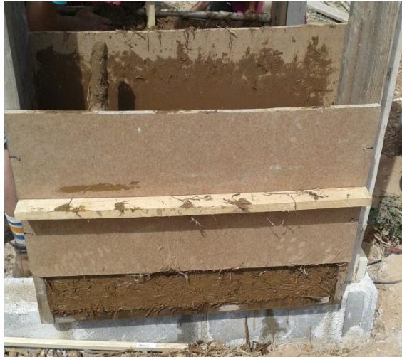
Figura 21. Construcción con tierra aligerada
