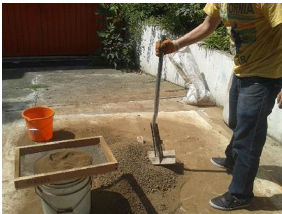
Figura 31. Apisonado de los residuos de excavación
