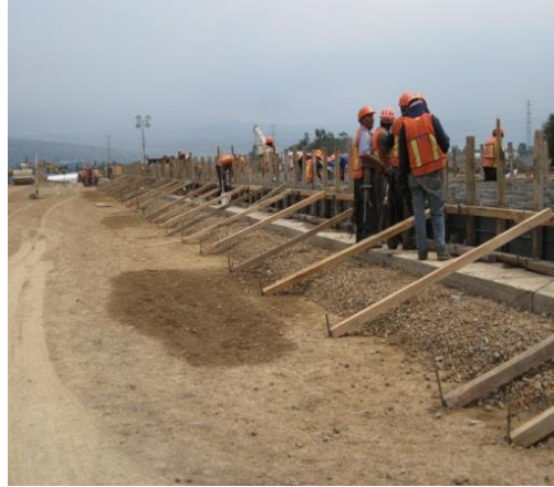
Figura 12. Construcción de la Autopista Urbana Sur Fuente: Granell, 2014.
