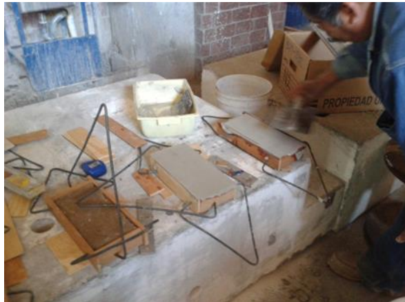
Figura 62. Adición de la mezcla sobre la superficie de los ladrillos
