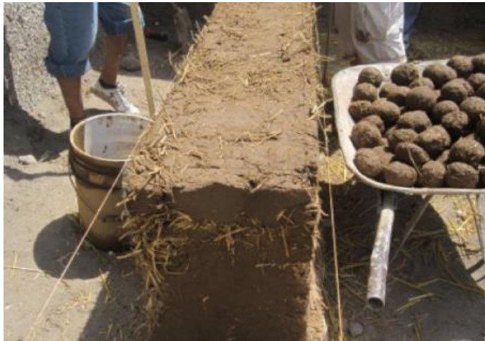
Figura 20. Construcción de un muro con COB
