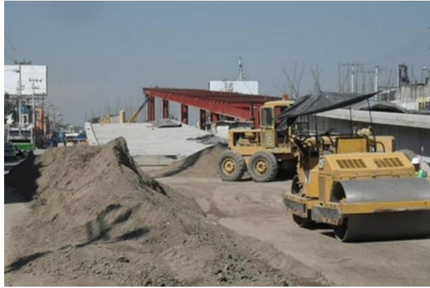
Figura 14. Construcción de bases hidráulicas empleando material reciclado, Av. Chimalhuacán D.F.
