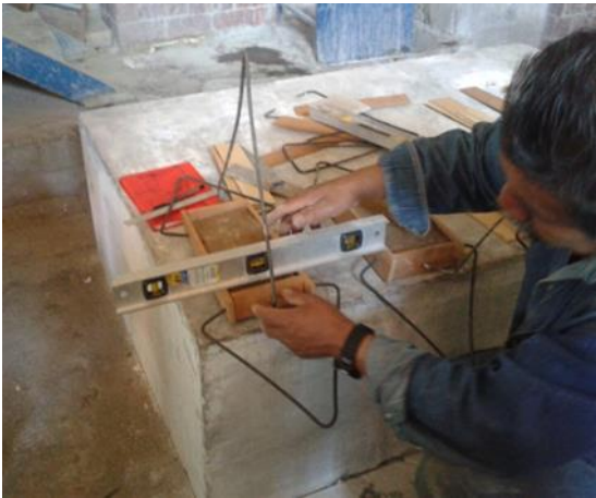
Figura 61. Nivelado de las piezas de confinamiento
