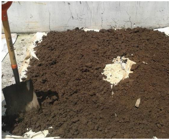
Figura 30. Secado de los residuos de excavación
