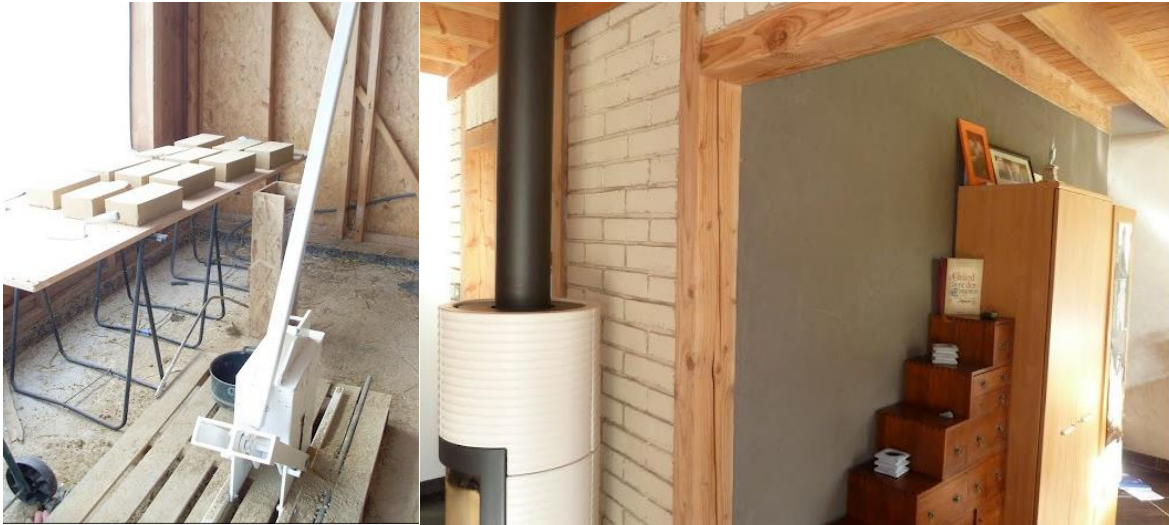
Fig. 09 Elaboración de tierra comprimida para su utilización en la construcción de vivienda. Fotografía: Tomada de http://www.ecoconstructeurs.fr/realisations/2/maison-paille.htm
