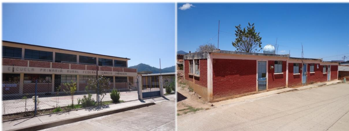
Fig. 48 Escuela primaria y casa de maestros. Fueron las primeras construcciones con materiales industrializados y que en la actualidad presentan un gran deterioro. Fotografía: De la autora.
