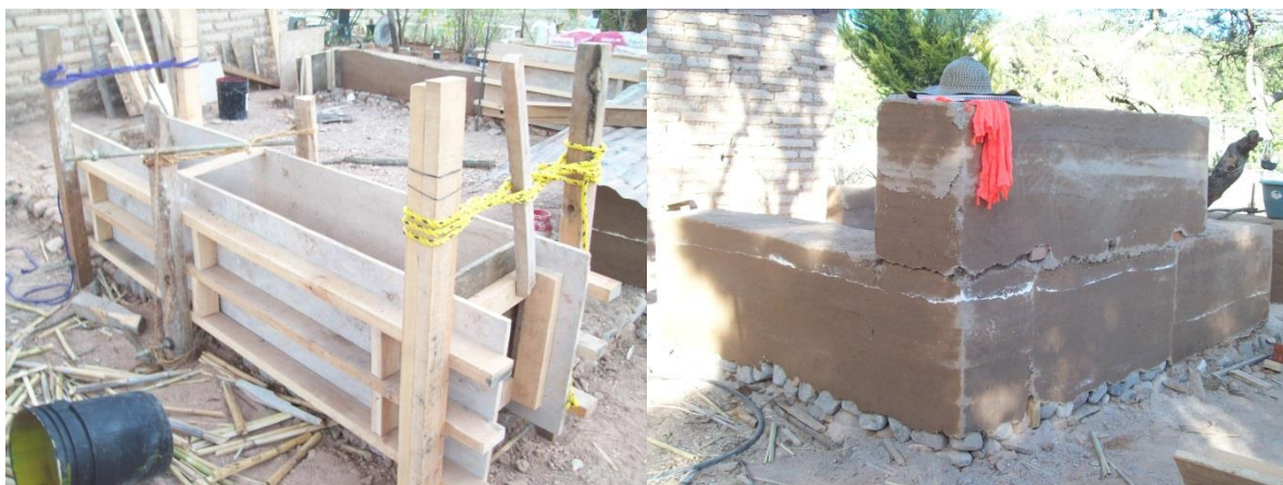
Fig. 07 A la izquierda se observa el encofrado de madera que se construye para realizar un muro de tapial. A la derecha, el resultado de la compactación de la tierra en el encofrado. Fotografía: Cortesía de Alfonso Luna.
