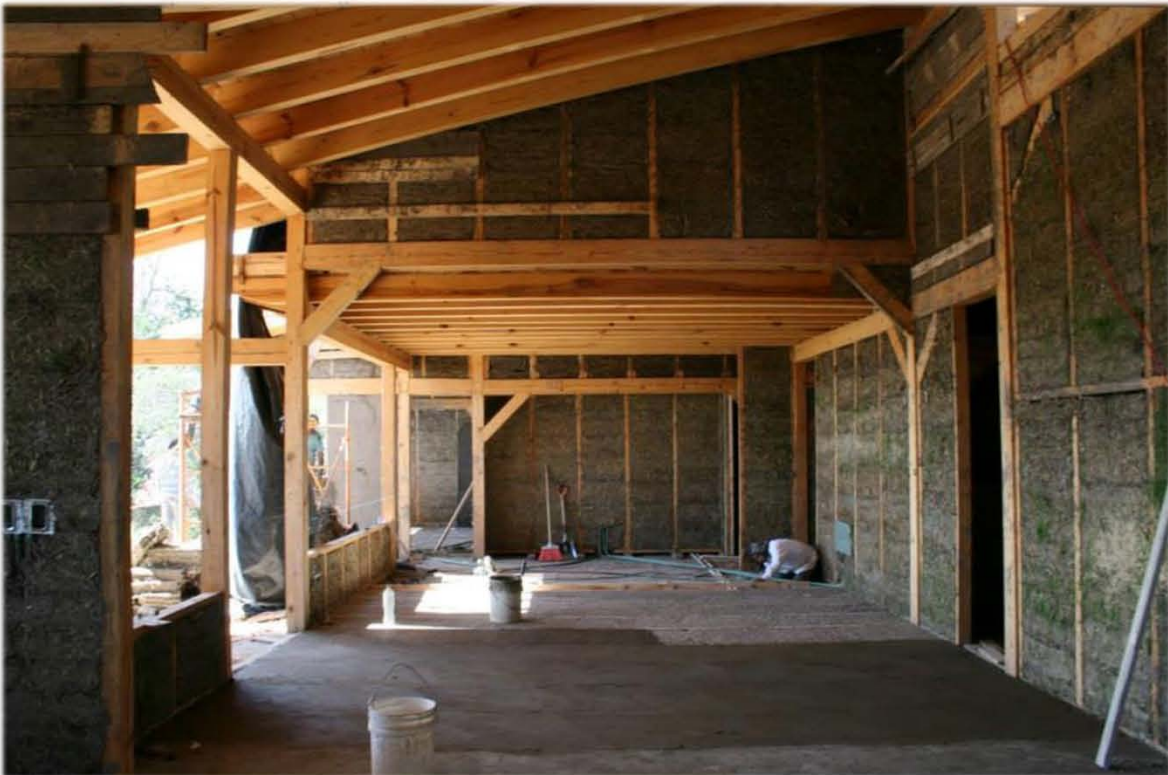
Fig. 11 La conformación de los muros en esta casa se hizo con pajarcilla. Fotografía: Tomada de http://www.tierracruda.com/trabajo#/casa-corazon/ .
