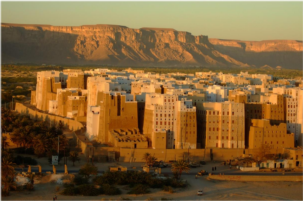
Fig. 02 Shibam: La Manhattan del desierto, sus edificios datan del siglo XVI. Fotografía: Will de Freitas.
