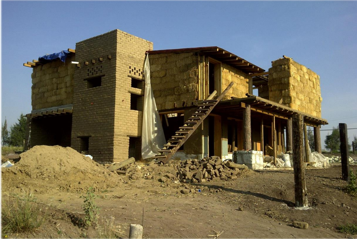
Fig. 10 Construcción de vivienda con adobe y pacas de paja con estructura portante de madera. Fotografía: Cortesía de Eco-Constructores Oaxaca.
