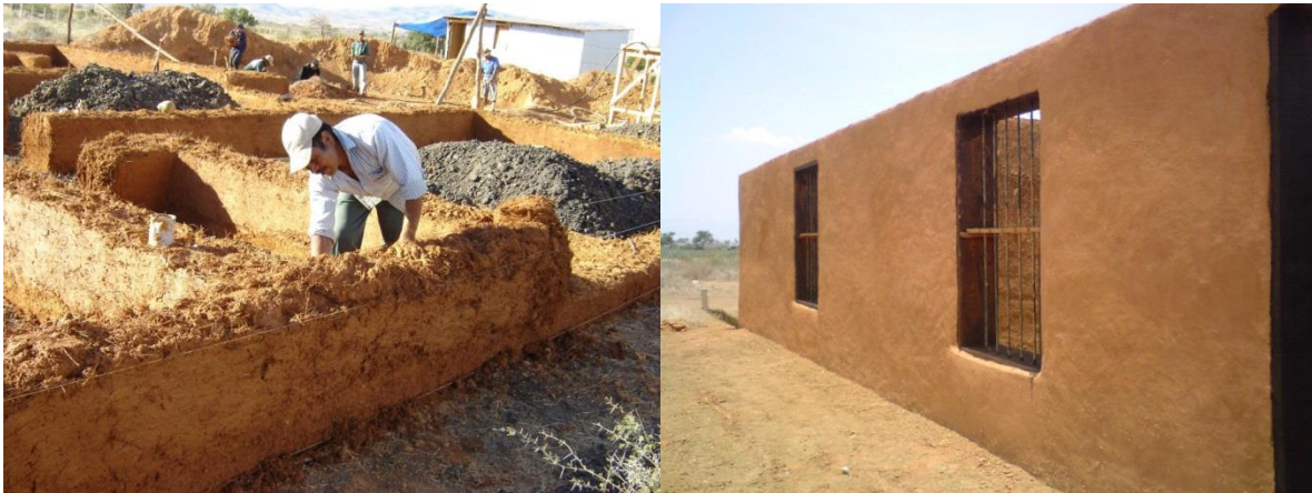
Fig. 08 Construcción de una vivienda en Miahuatlán de Porfirio Díaz, Oaxaca, con el sistema de tierra anegada. Fotografía: Cortesía de Eco-Constructores Oaxaca.
