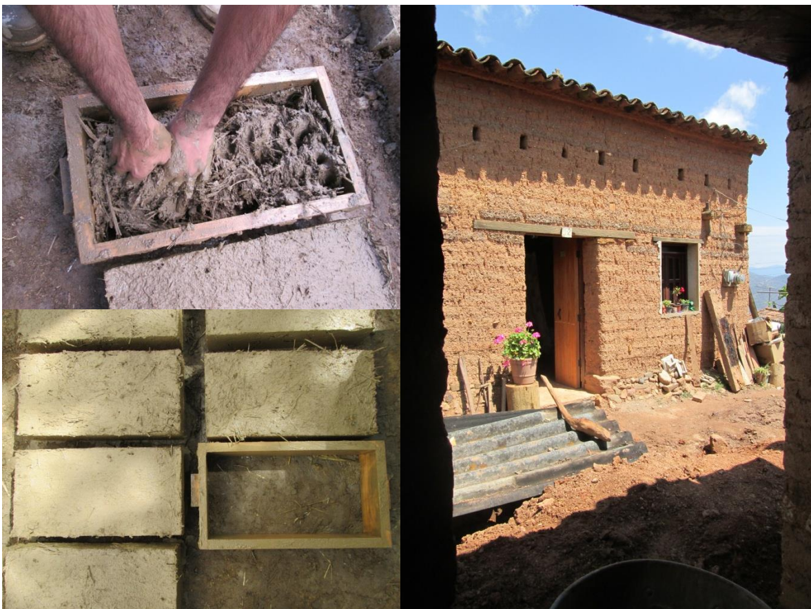
Fig. 04 La elaboración de adobes y su uso en la construcción de vivienda. Fotografía: De la Autora.
