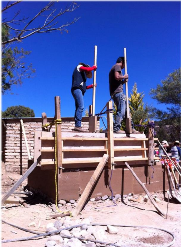
Fig. 06 Construcción de un muro de tapial, en Nochixtlán, Oaxaca. Fotografía: Cortesía de Alfonso Luna.
