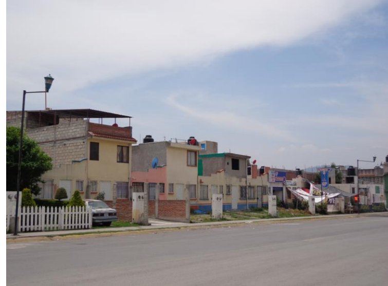
Imagen 20: Modificaciones a viviendas en conjunto urbano Colinas del Sol (social progresivo), mpio. de Almoloya de Juárez.
