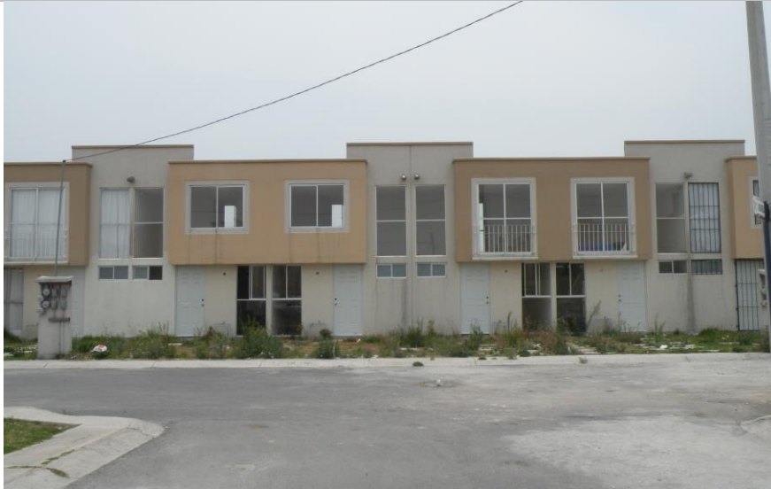
Imagen 45: Viviendas sin ocupar, en estado de abandono, en calle de retorno. Conjunto urbano Galaxia Lerma , mpio. de Lerma.
