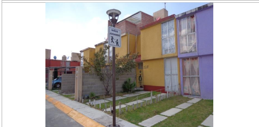
Imágenes 69 y 70: Colinas del sol ; organización vecinal en manzana detrás de escuelas. Postes de alumbrado en buen estado, señalización, limpieza de calles a cargo de los vecinos.
