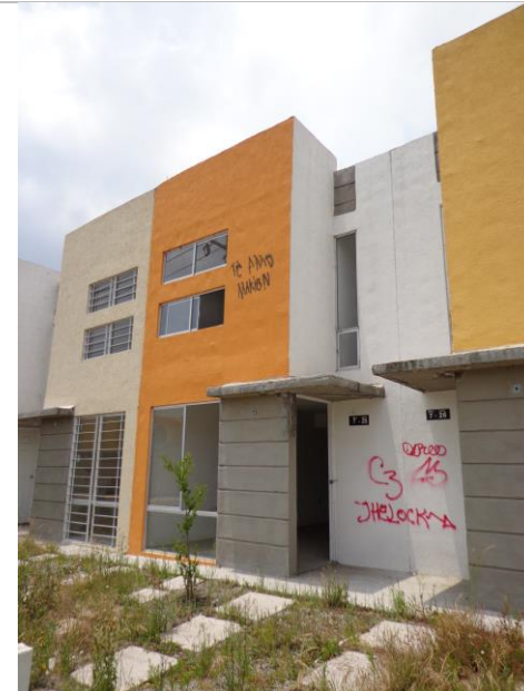
Imagen 50: Vivienda vandalizada en conjunto Valle del Nevado , mpio. de Calimaya.
