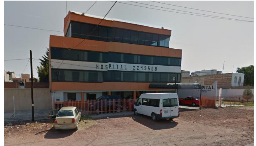
Hospital privado de tres niveles.
