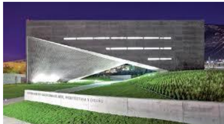
Centro Roberto Garza Sada, Escuela de Arte, Arquitectura y Diseño (Monterrey, México). http://www.noticiasarquitectura.info/mexico-centro-roberto-garza-sada-de-arte-arquitectura-y-diseno-universidad-de-monterrey-tadao-ando/
