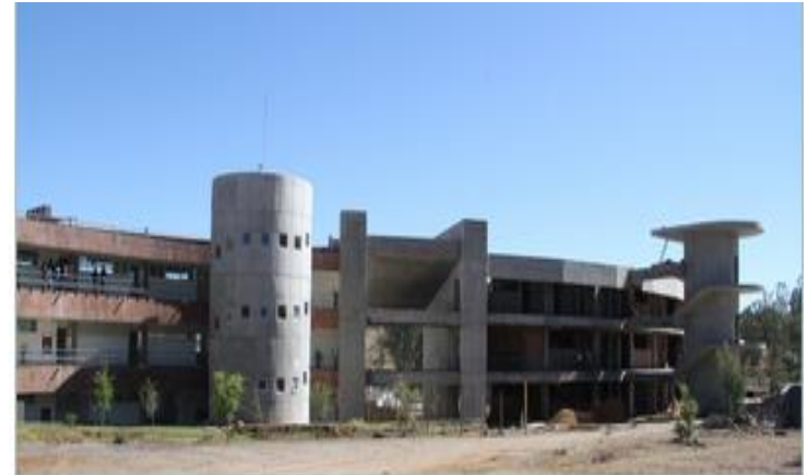
Construcción de la Primera etapa http://oferta.unam.mx/escuela-facultad/35/escuela-nacional-de-estudios-superiores-unidad-morelia
