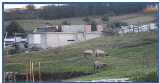
Figura 18. Construcción de casas rápidas para ocupar el terreno
