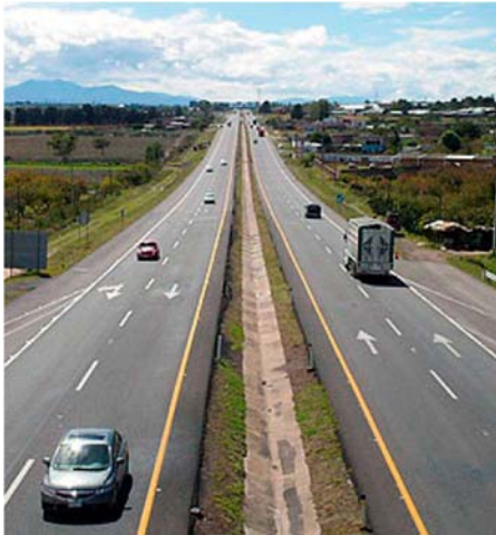
Foto 1: Carretera Federal Irapuato – La Piedad
