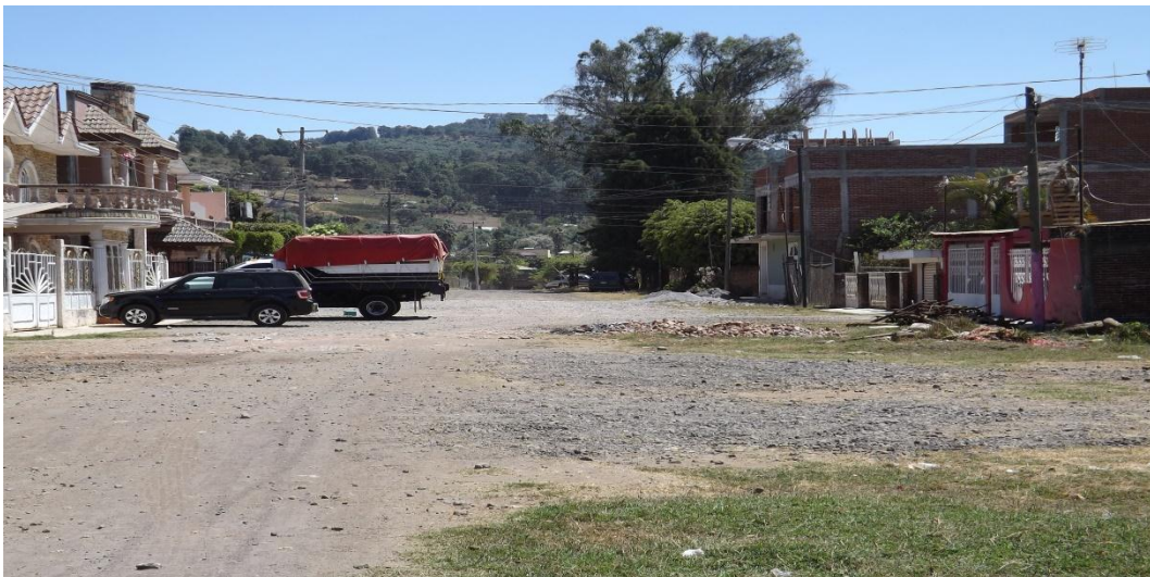
Fotografía 3.2.- Vialidad primaria dentro de la colonia.
