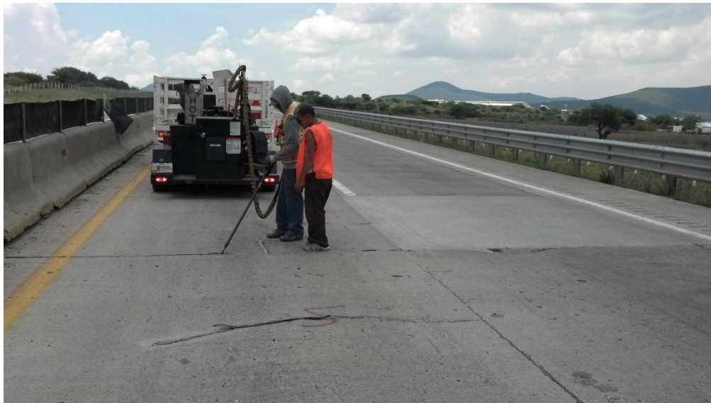
Fotografía 2.5. Sellado de Juntas y grietas en un pavimento rígido.
