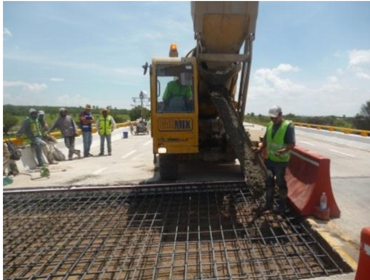
Fotografía 2.3 Losa de concreto armada
