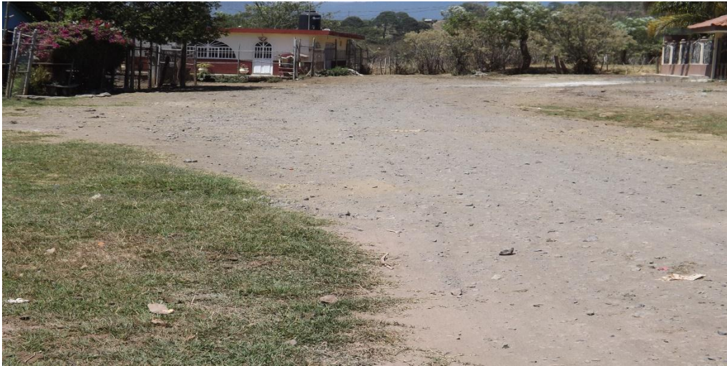
Fotografía 3.1.- Vialidad primaria dentro de la colonia.
