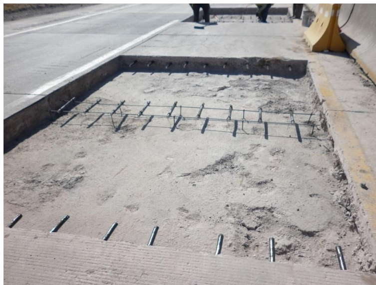
Fotografía 2.2 Losa de concreto con pasajuntas.
