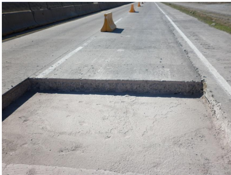
Fotografía 2.1 Losa de concreto simple.
