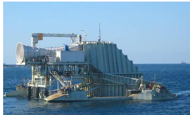
(c) Prototipo de una OWC construida en Port Kembla en New South Wales, Australia.
