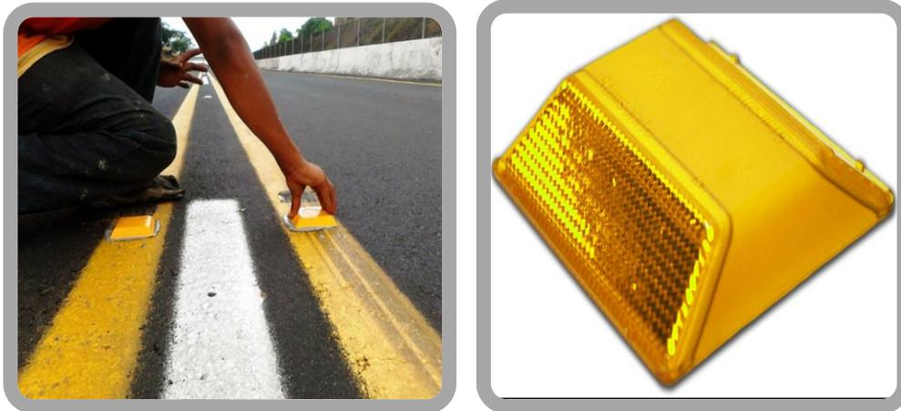
Figura 181: COLOCACIÓN Y EJEMPLO DE VIALETAS
