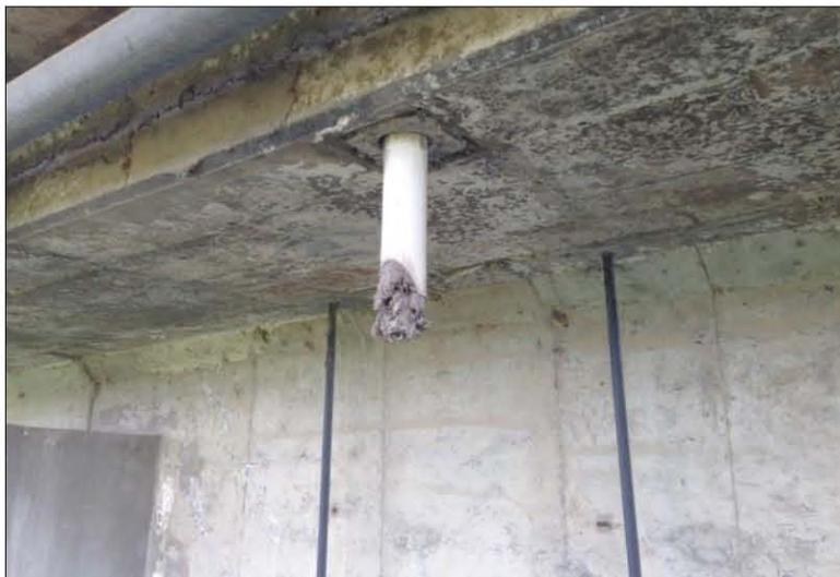
Detalle donde se observa un dren obstruido con tierra y basura, entre los diafragmas N° 4 y 5 , tramo 3-4, lado derecho de la estructura.
