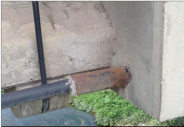
Detalle donde se observan los ductos con corrosión en los bloques desviadores de los diafragmas, tramo 3-4, lado derecho de la estructura.
