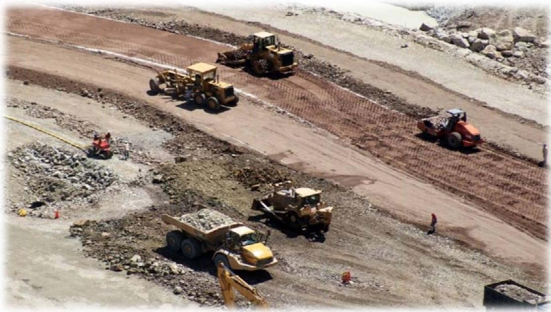
*Figura 2.2.- Colocación e incremento de las propiedades de los materiales en el P.H. La Yesca*
