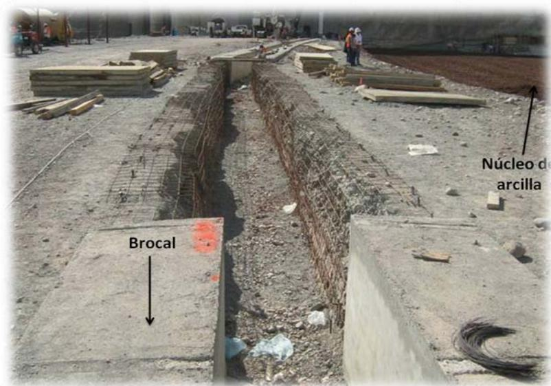
Figura 5.15.- Construcción del brocal de la ataguía aguas arriba.
