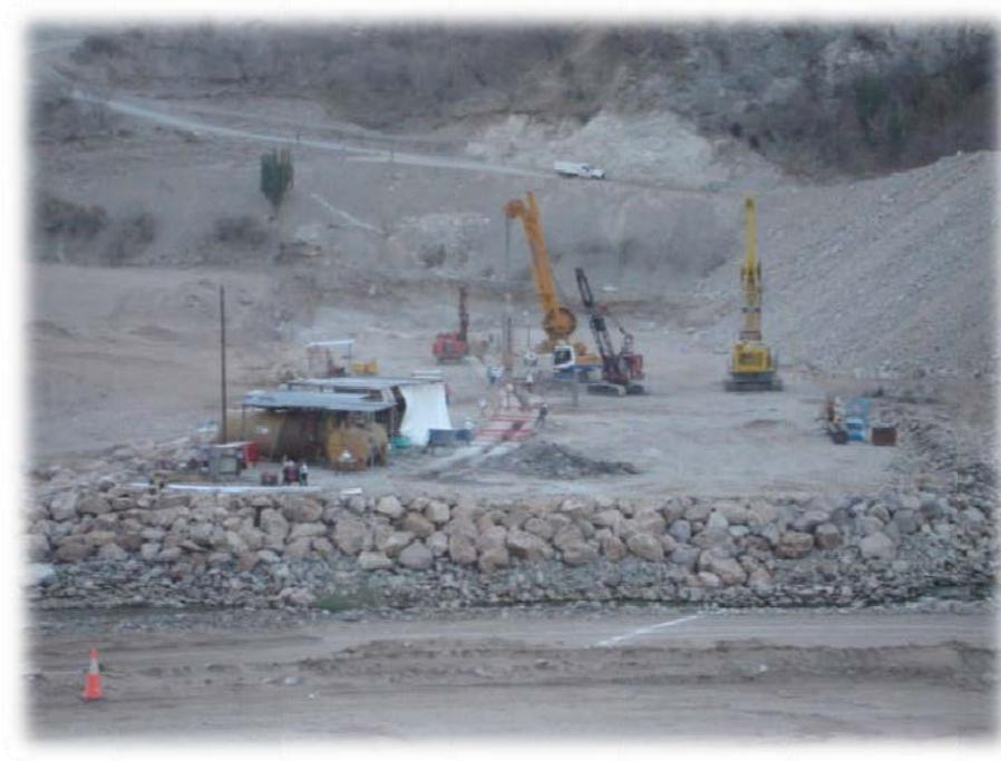
*Figura 5.9.- Plataforma de trabajo de la primera etapa del muro pantalla en la ataguía aguas arriba sobre la margen derecha del cauce del río.*
