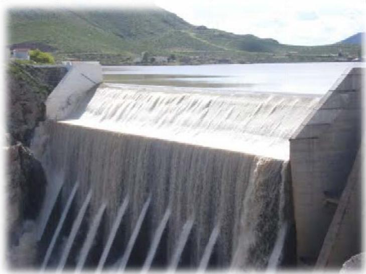
*Figura 1.2.5.- Cortina tipo aligerada con contrafuertes. Presa Francisco I. Madero*
