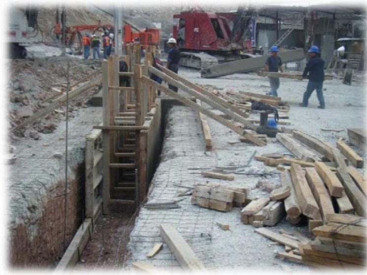
Figura 5.14.- Instalación de la cimbra del brocal guía para alojar el equipo de excavación (almeja), ataguía aguas abajo.
