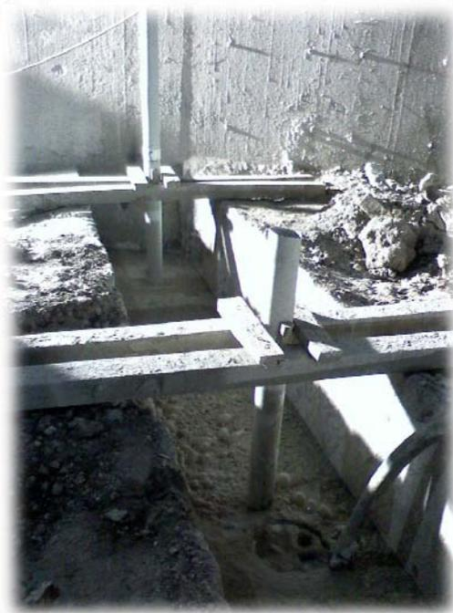
*Figura 5.25.- Colocación de los tubos guía para los barrenos de perforación*
