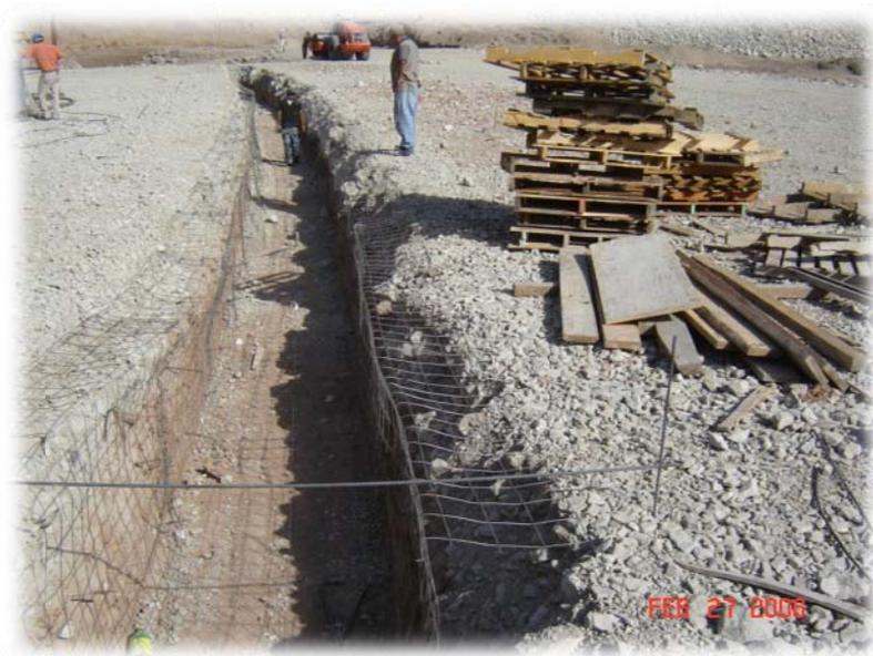
*Figura 5.13.- Excavación del brocal guía para alojar el equipo de excavación (almeja), ataguía aguas arriba.*
