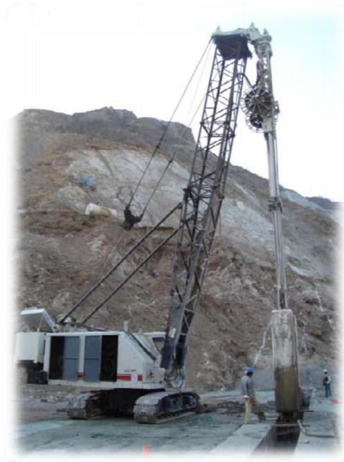
*Figura 5.29.- Equipo Soilmeac utilizado para la construcción de la pantalla aguas abajo*
