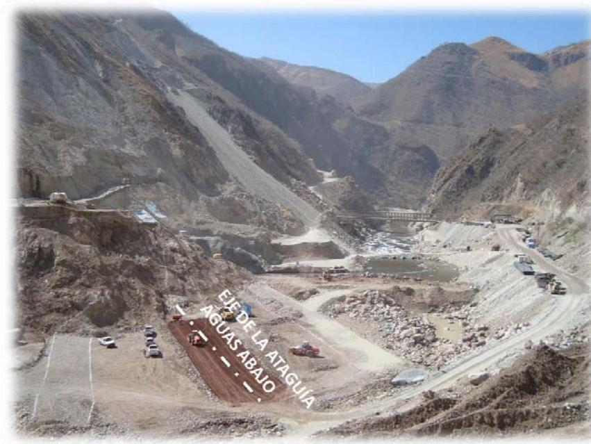
*Figura 5.11.- Plataforma que alojó las instalaciones para la ejecución de la pantalla impermeable aguas abajo de la presa.*
