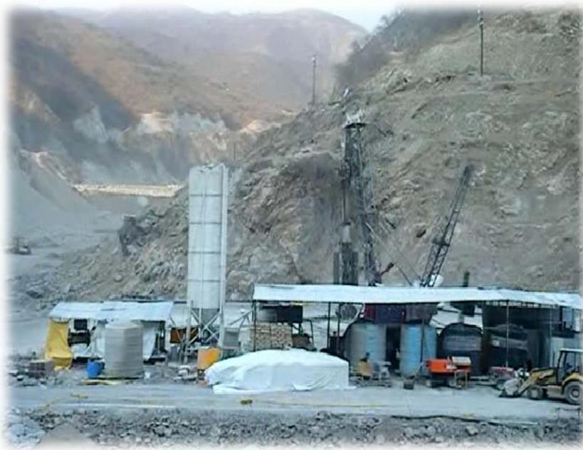
*Figura 5.12.- Instalaciones en campo para la ejecución de la preparación de mezclas para el inyectado y construcción del muro plástico.*
