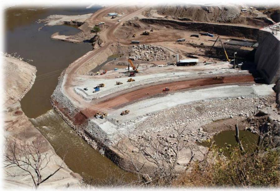
*Figura 5.10.- Plataforma de trabajo en la segunda etapa del muro pantalla en la ataguía aguas arriba sobre la margen izquierda del cauce del río.*
