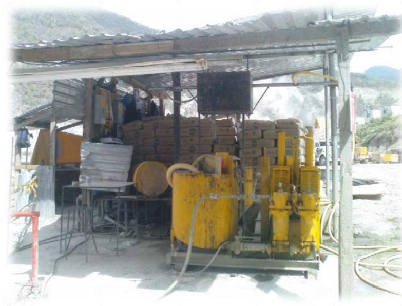
*Figura 5.17.- Equipo de mezclado de la mezcla autofraguante e inyectado.*
