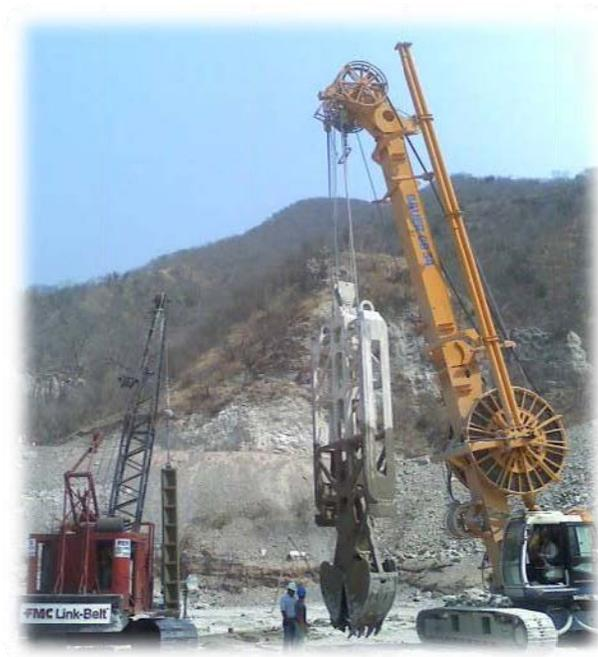
*Figura 5.27.- A la derecha equipo Bauer GB 34 de excavación para la pantalla impermeable y a la izquierda equipo Link Belt adicionando con cincel-trepano, ataguía aguas arriba del P.H. La Yesca*
