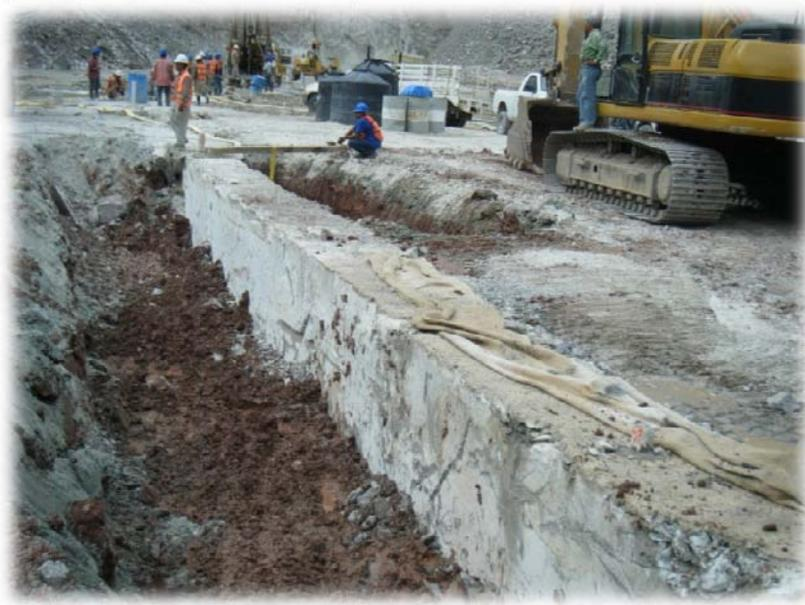
*Figura 5.26.- Retiro del brocal guía de la pantalla flexible-ataguía aguas abajo*
