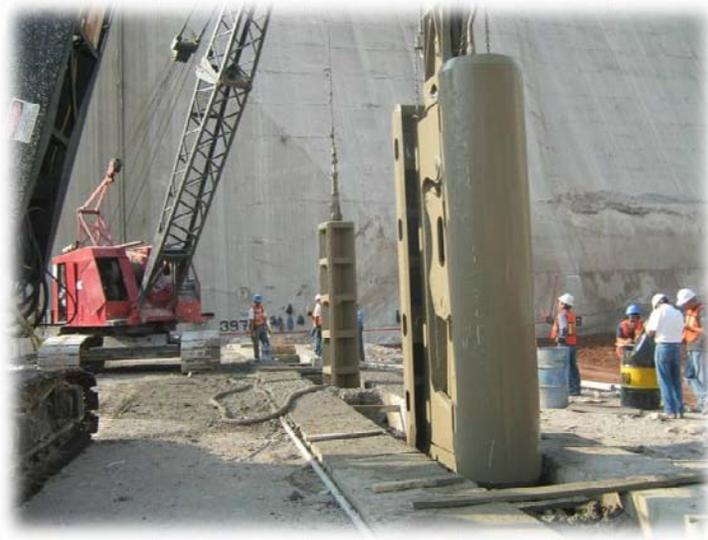
*Figura 5.28. Al fondo el equipo Link Belt adicionando con cincel-trepano y al frente el equipo Soilmeac de excavación para la pantalla impermeable. Equipo de excavación y demolición en la pantalla aguas arriba*
