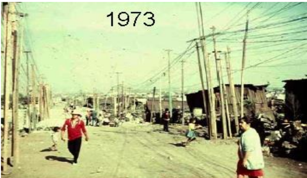
Figura 3.11. Proceso de electrificación.
