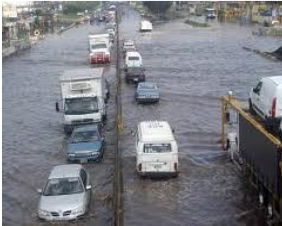
Inundación de la Autopista México-Puebla a la altura de “Caseta Vieja” Tomada de http://www.lazafra.com en 2011.
