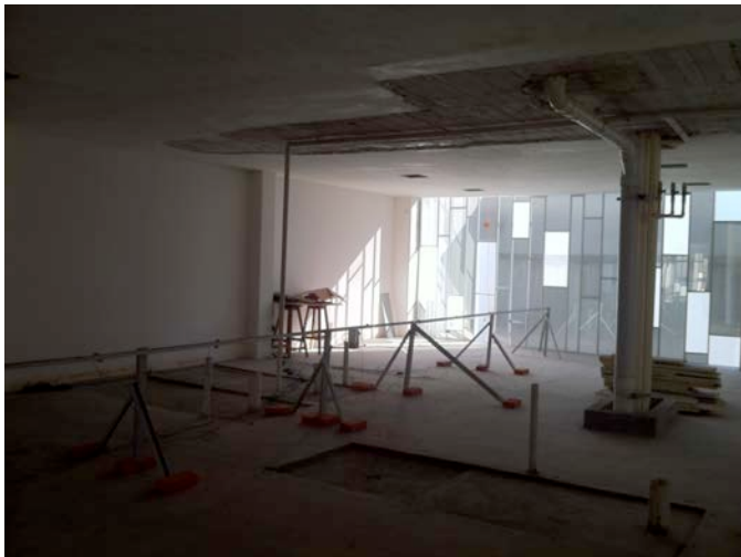
Fig. 9. Ubicación de 11 fotómetros a una altura de plano de trabajo, (tercer nivel). Centro Histórico Ciudad de México.
