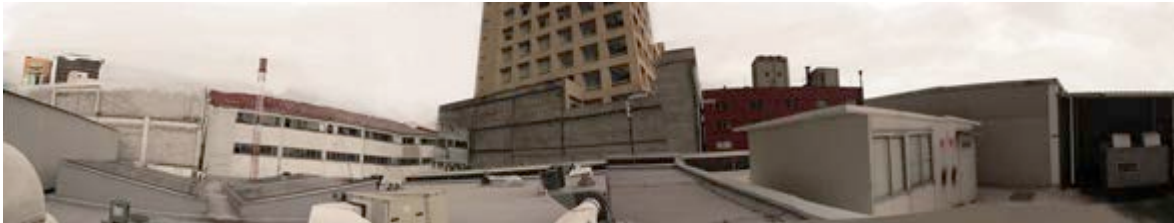
Fig. 2. Contexto Urbano – Arquitectónico. Porción: sur – oeste – norte. El edificio que representa la mayor obstrucción en la incidencia de la luz natural, debido a su altura (13 niveles) se ubica hacia el lado oeste (av. Insurgentes).
