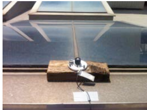
Fig. 13. Fotómetro No.22, sobre domo en azotea.
