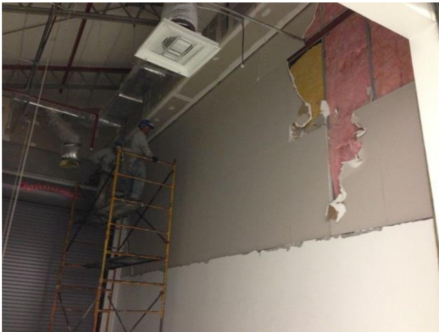
FIGURA 1.13 Imágenes del área a remodelar. Retiro de muro Memoria fotográfica del proyecto "Chichen Itza"
