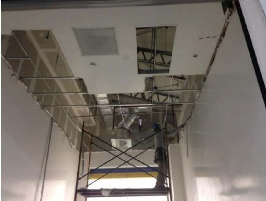
FIGURA 1.7 Imágenes del área a remodelar. Retiro de plafón Memoria fotográfica del proyecto "Chichen Itza"
