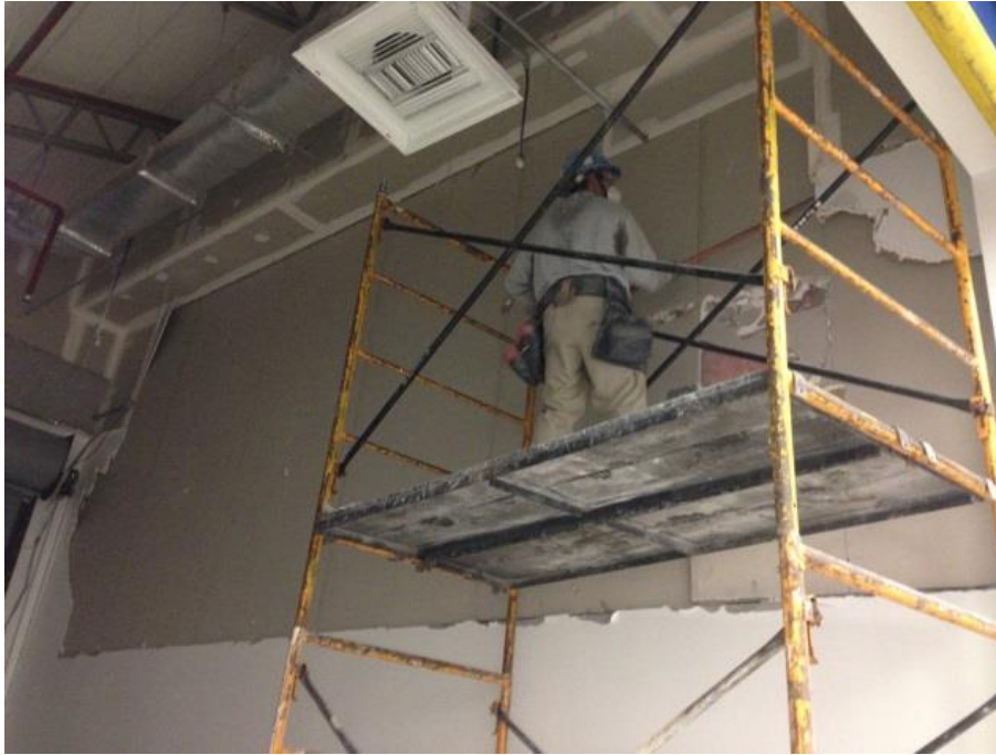
FIGURA 1.12 Imágenes del área a remodelar. Retiro de muro Memoria fotográfica del proyecto "Chichen Itza"
