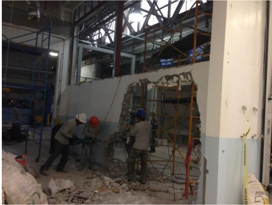
FIGURA 1.18 Imágenes del área a remodelar. Retiro de muro Memoria fotográfica del proyecto "Chichen Itza"
