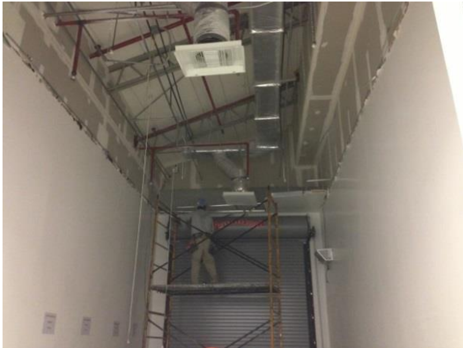
FIGURA 1.8 Imágenes del área a remodelar. Retiro de plafón Memoria fotográfica del proyecto "Chichen Itza"
