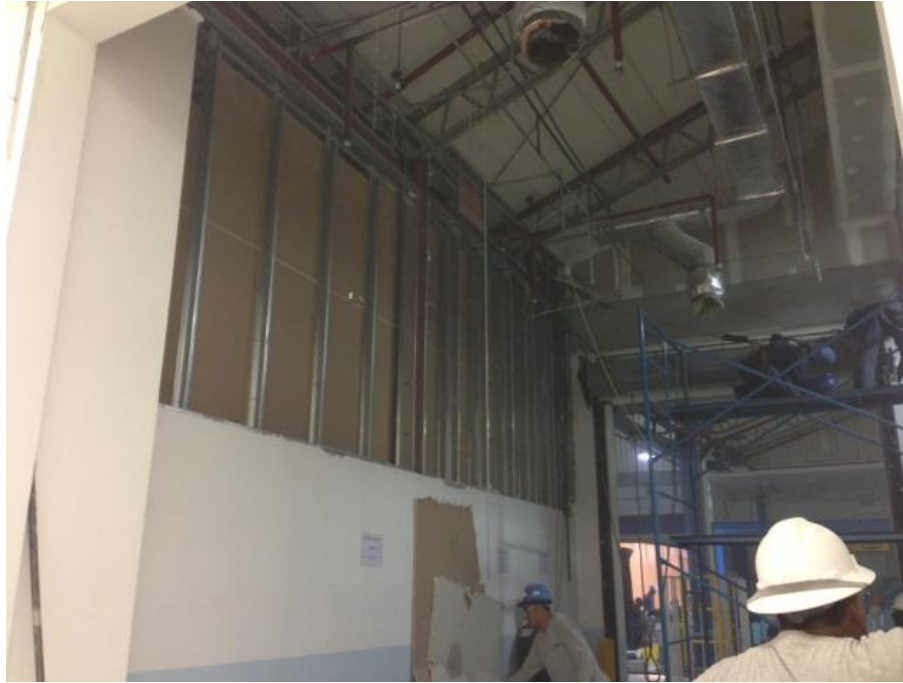
FIGURA 1.16 Imágenes del área a remodelar. Retiro de muro Memoria fotográfica del proyecto "Chichen Itza"
