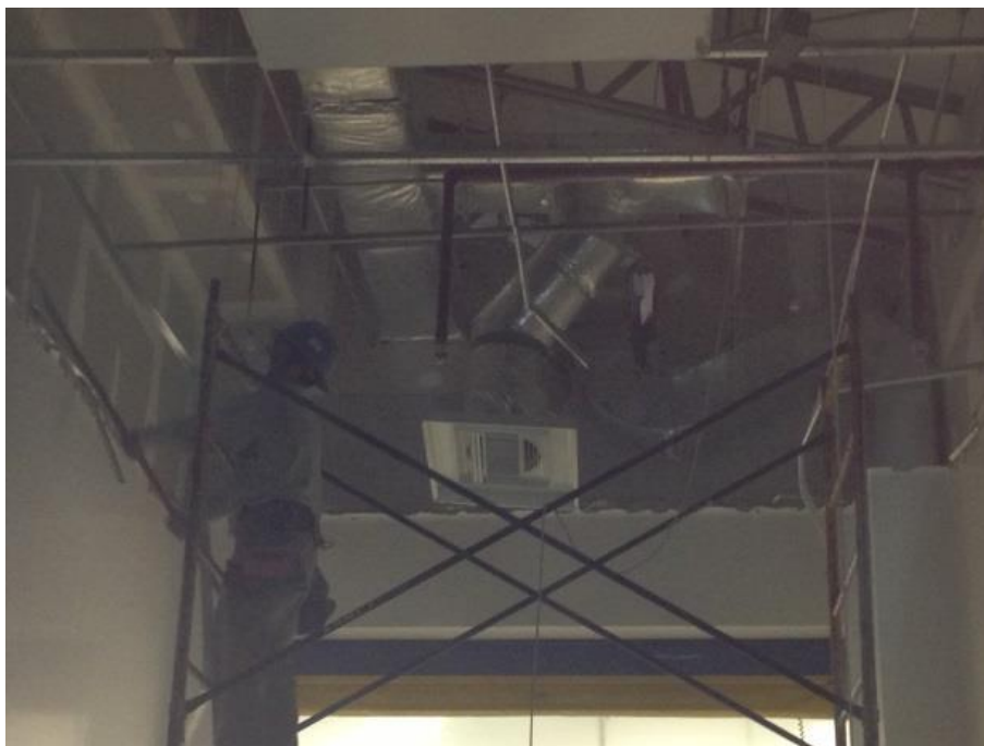
FIGURA 1.10 Imágenes del área a remodelar. Retiro de plafón Memoria fotográfica del proyecto "Chichen Itza"
