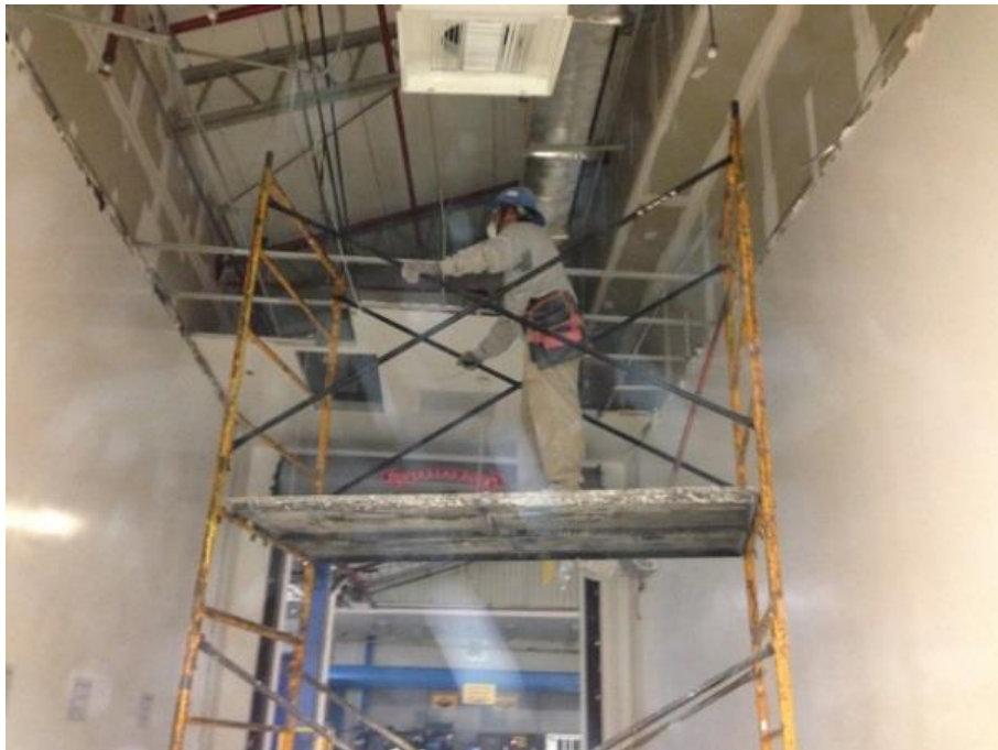
FIGURA 1.6 Imágenes del área a remodelar. Retiro de plafón Memoria fotográfica del proyecto “Chichen Itza”
