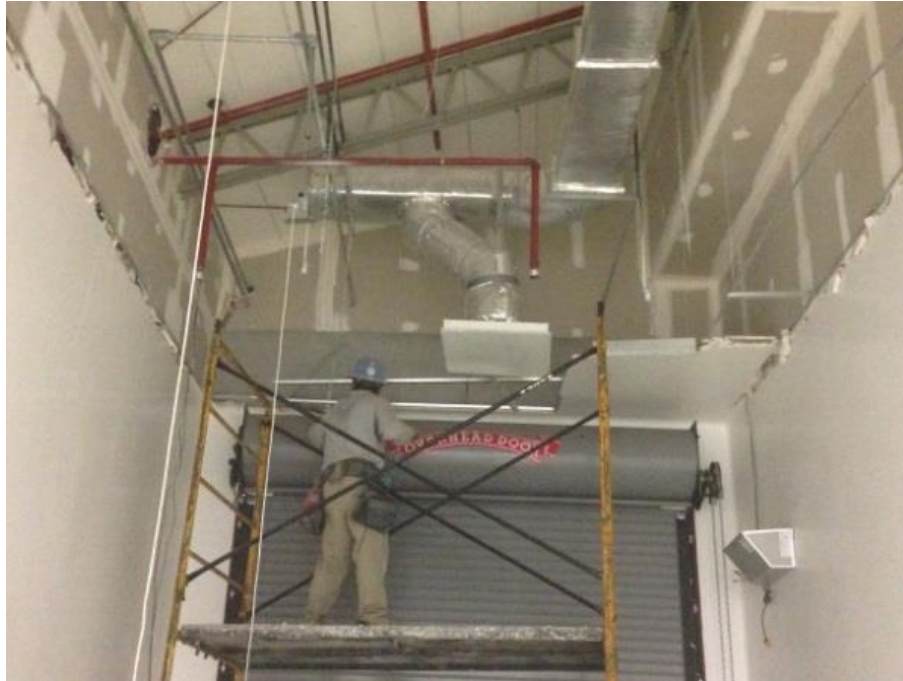
FIGURA 1.9 Imágenes del área a remodelar. Retiro de plafón Memoria fotográfica del proyecto "Chichen Itza"
