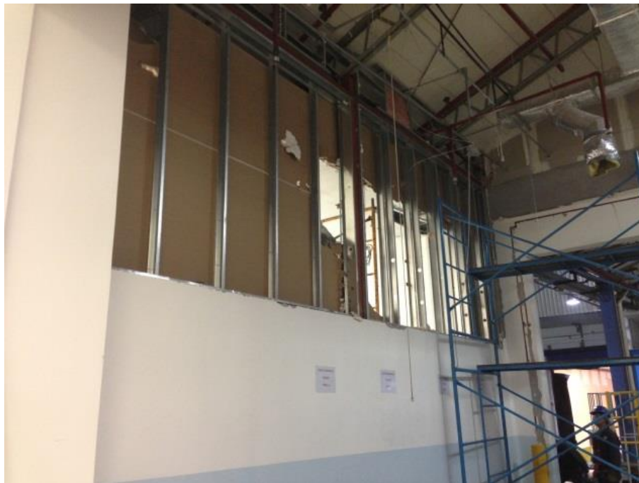
FIGURA 1.17 Imágenes del área a remodelar. Retiro de muro Memoria fotográfica del proyecto "Chichen Itza"
