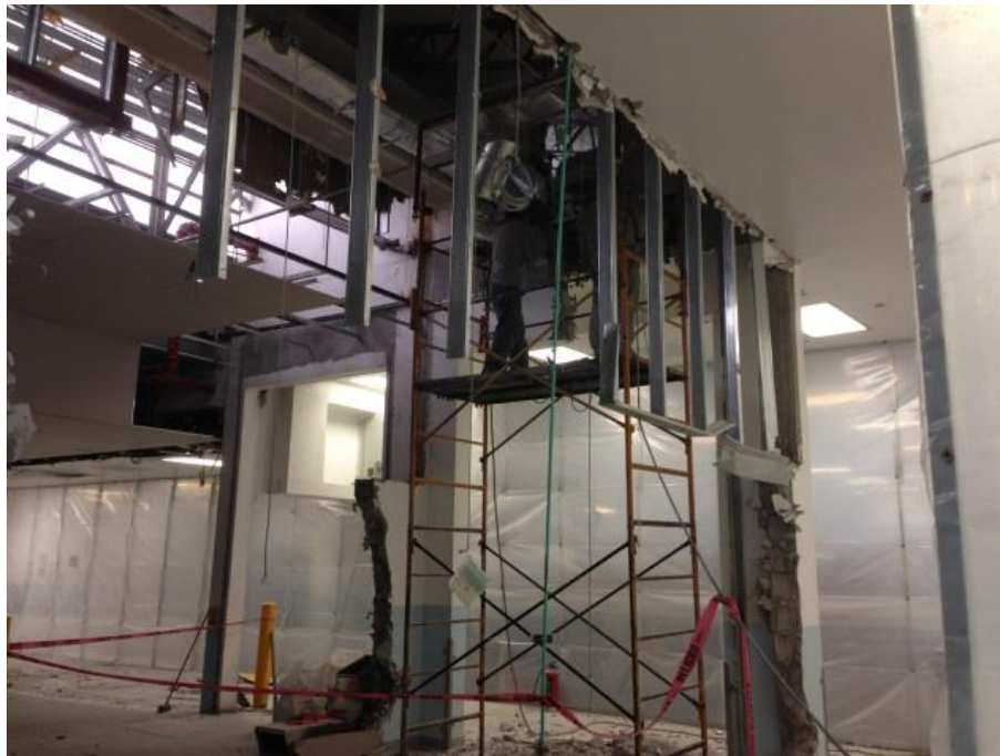
FIGURA 1.19 Imágenes del área a remodelar. Retiro de muro Memoria fotográfica del proyecto "Chichen Itza"
