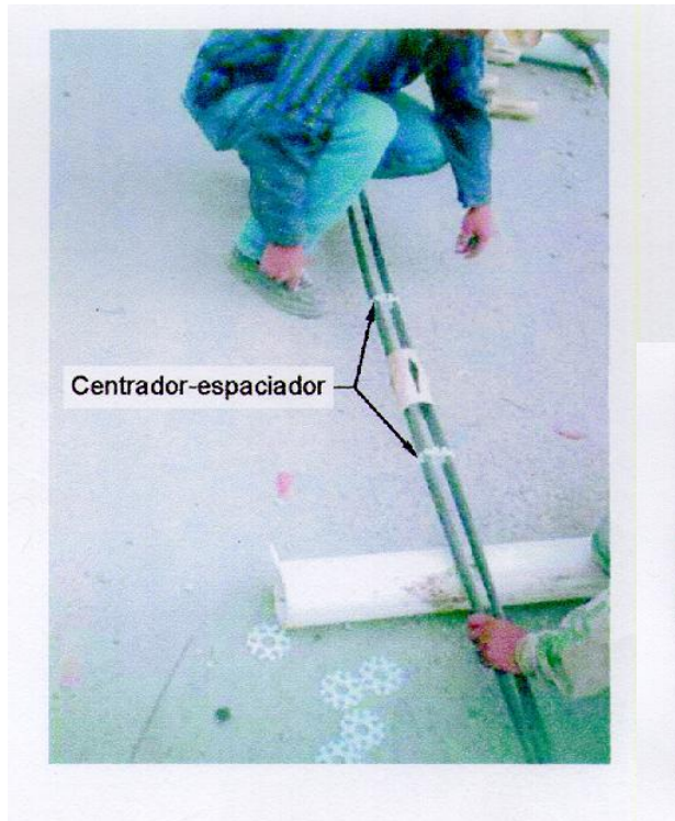
Figura 1.9 Colocación de centradores y espaciadores.
