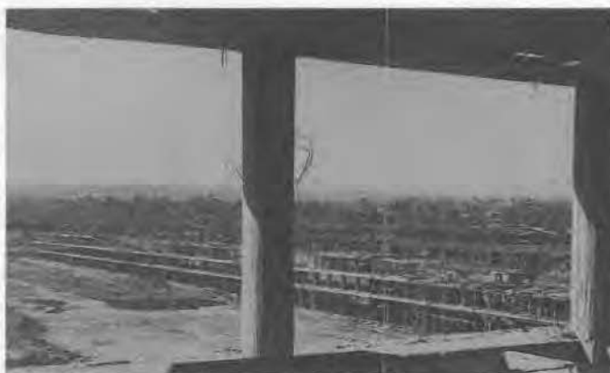
Vista del "tren de humanidades", captada desde la parte posterior. Avance de la obra, 10 de febrero 1951
