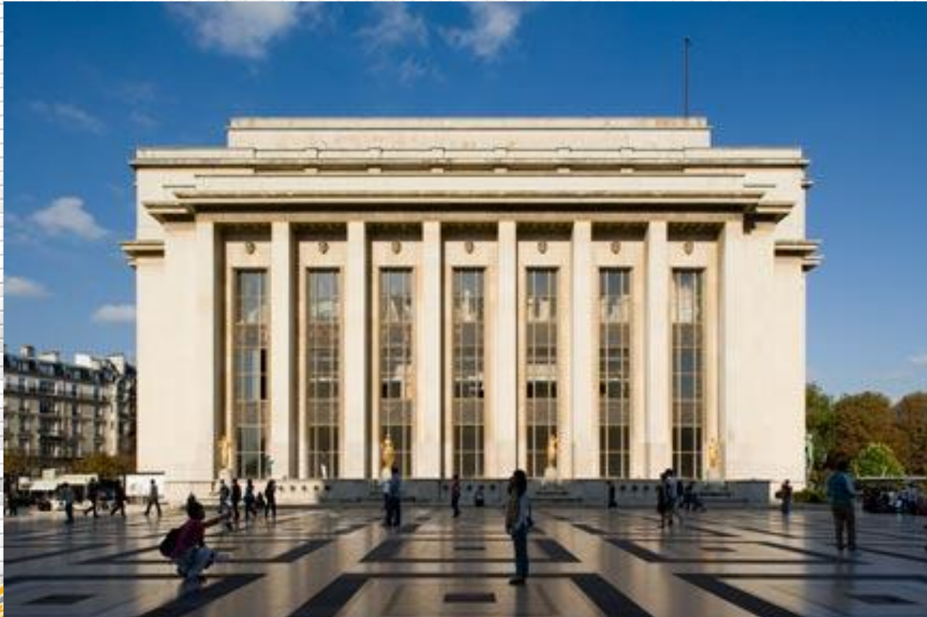
Imagen 46. Cité de l'Architecture et du Patrimoine
