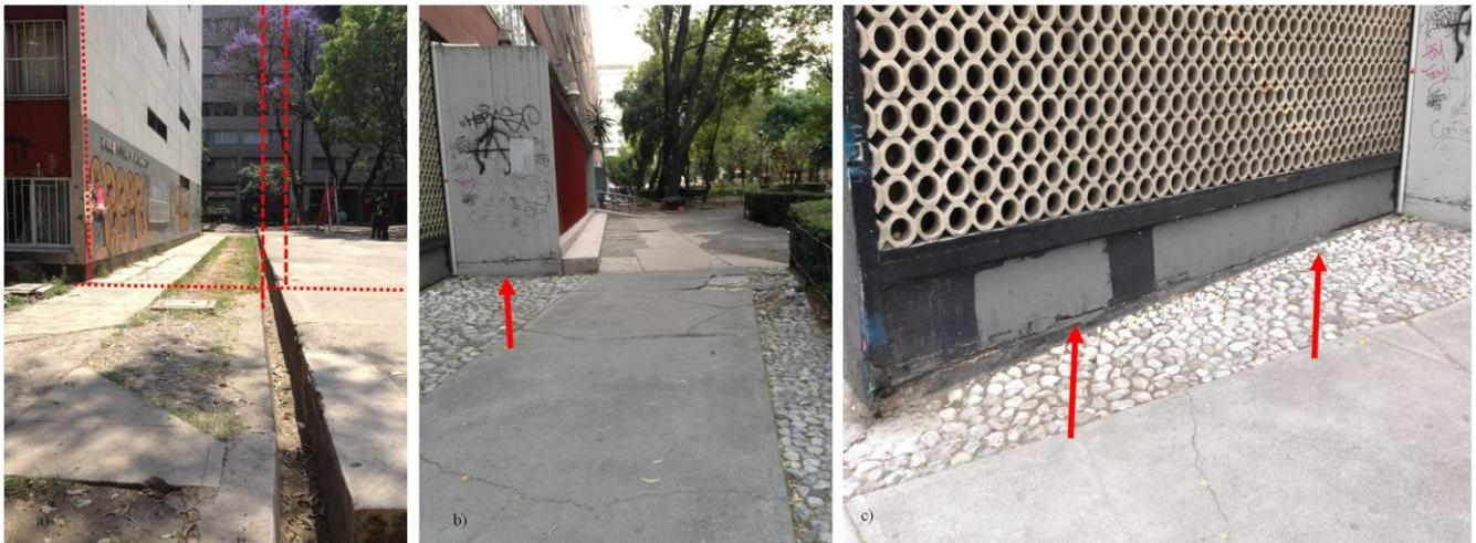
Fuente: Fotografía tomada por la autora, en trabajo de campo, 7 de septiembre 2013. a) Diferencia de los desniveles dentro del Conjunto Habitacional Nonoalco-Tlatelolco, b) Daños y añadido de escalón por asentamiento y c) Agrietamiento por asentamiento del edificio.
