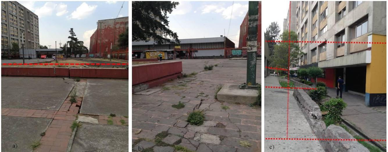
Fuente: Fotografía tomada por la autora, en trabajo de campo, 7 de septiembre 2013. a) Hundimiento diferencial, b) Agrietamiento del terreno y c) Nivelación diferenciales Metro Tlatelolco.
