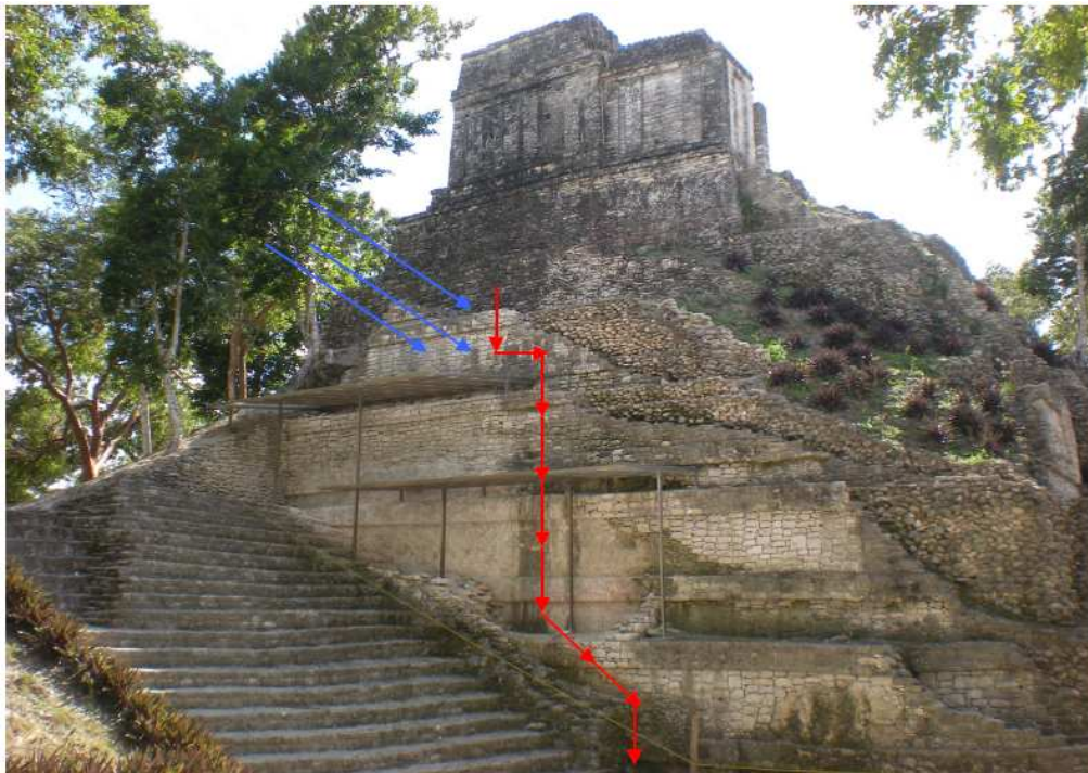
Ilustración 21: Trayecto de escurrimiento de agua en el basamento por colocación deficiente del techado.
