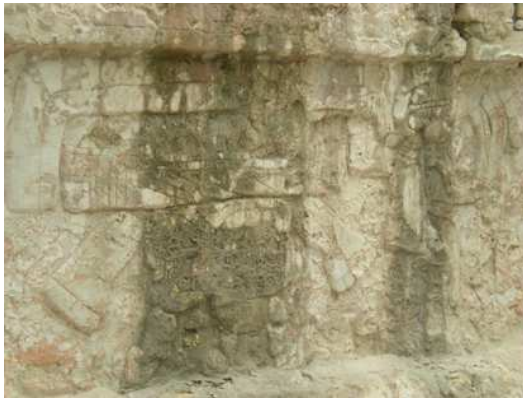
Ilustración 22: Sección húmeda con biofilm y karstificación.
