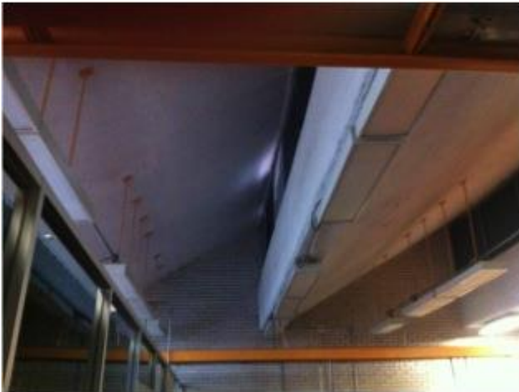
Figura 3.26 Techo del Laboratorio de forma irregular
