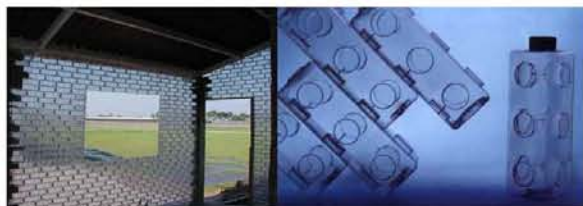
Fig 298. Emium se puede ensamblar para formar muros.
