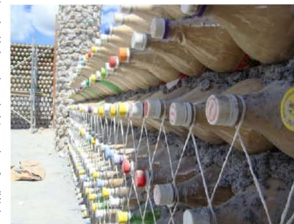
Fig 290. Ecotec usa la botella de refresco como elemento constructivo.
