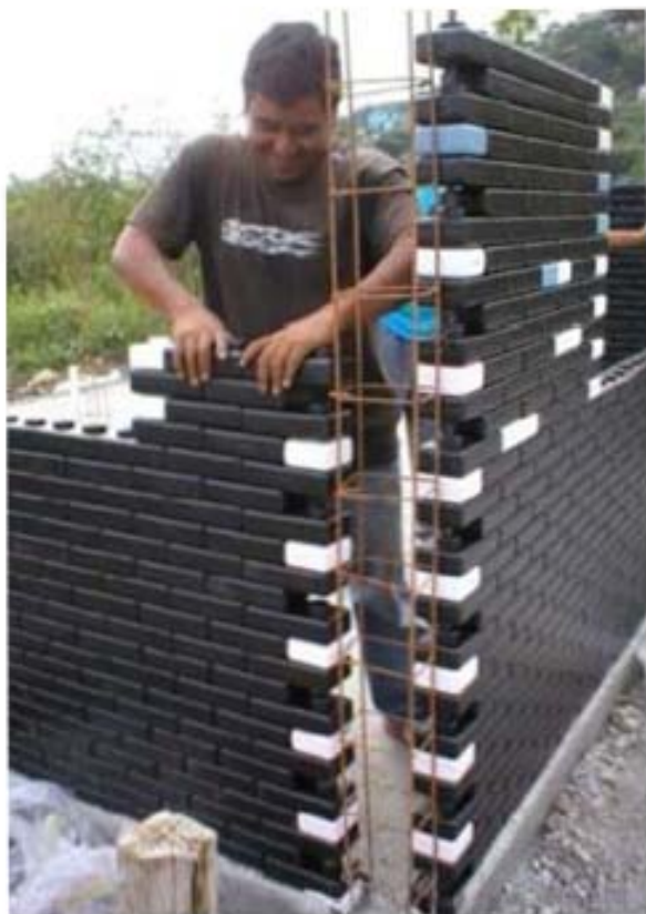
Fig 267. Muro armado con tabiques plásticos.
