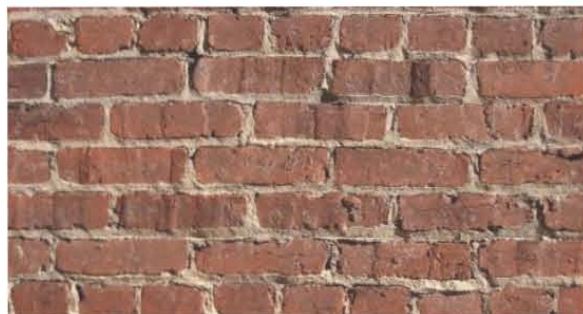
Fig 264. Muro de ladrillo.
