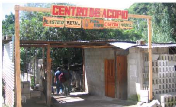
Fig 205. Los centros de reciclaje son arcaicos.
