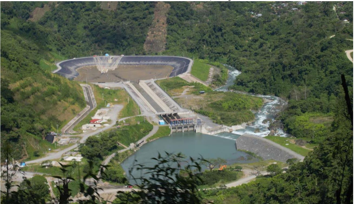
Foto 2. Hidroeléctrica HidroXacbal, Chajul*
