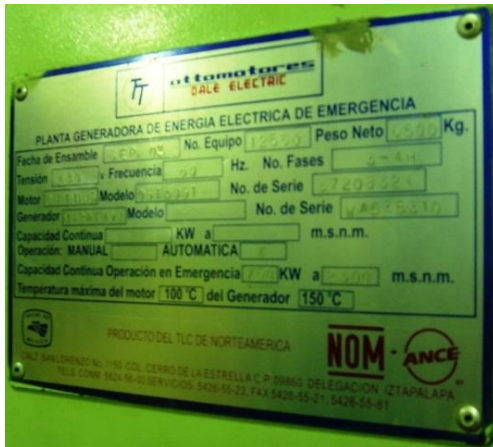
Fig. 6.8 – Placa de datos de Motogenerador de emergencia
