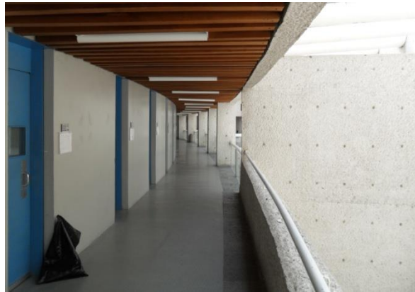
PASILLO, EDIFICIO DE AULAS.
