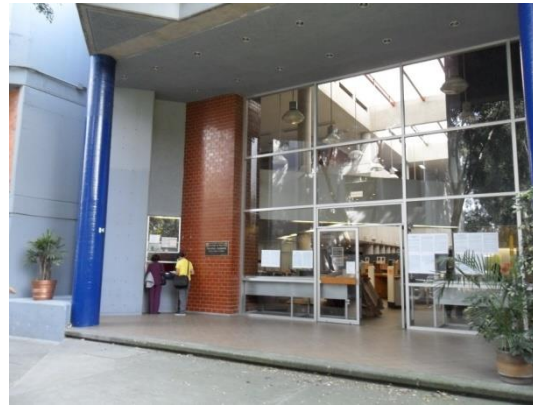
ACCESO A BIBLIOTECA
