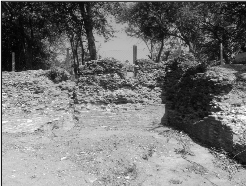
Figura 50. Muros de una antigua construcción colonial en el cementerio. Levantado con piedras de canto rodado, suele atribuirse su construcción a los primeros conquistadores en el siglo XVI; posiblemente se trataba de una primera iglesia. Al centro conserva un nicho. Fotografía propia, 2011.
