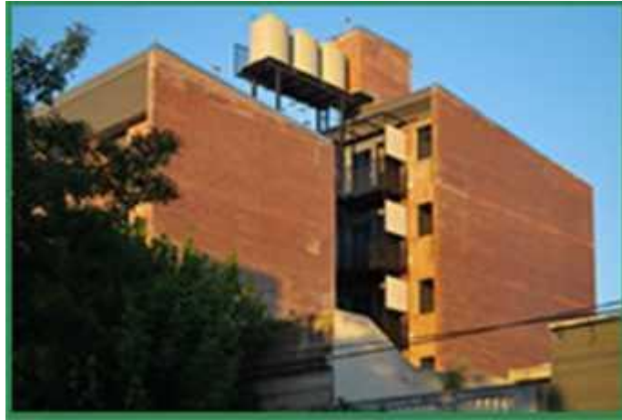
Figura 10.3 Tanques de agua en la azotea de un edificio.
