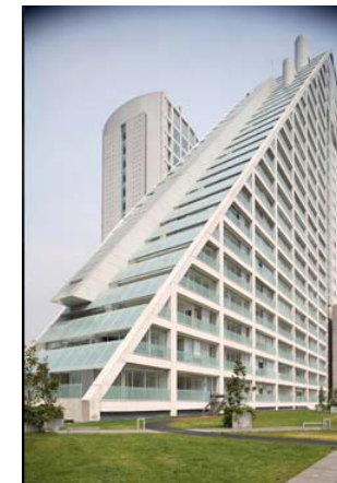
TORRE 2 FACHA SUR ESCALONADA
