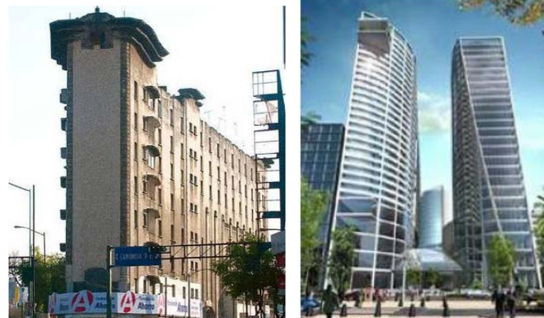
Lado izquierdo Edificio Ermita, 1930, lado derecho Reforma 222,2008. FUENTE: LA ARQUITECTURA EN LA VIVENDA Y LA CONFIGURACIÓN SISMICA
