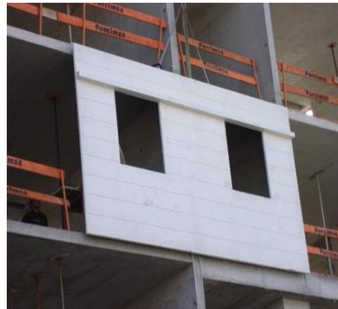
Paneles prefabricados para fachadas
