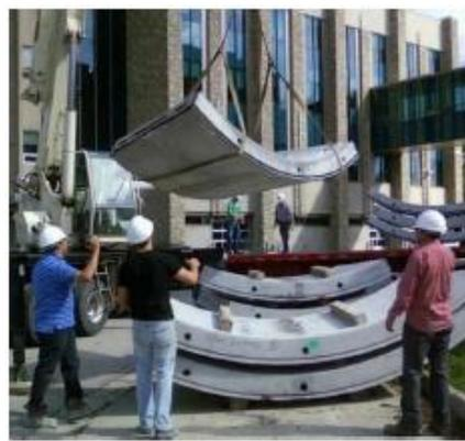
Dovelas prefabricadas (EEUU) para T.M.B
